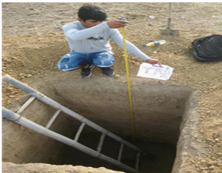
Figura N° 07: Calicata de 1.50 m de profundidad N° 2
