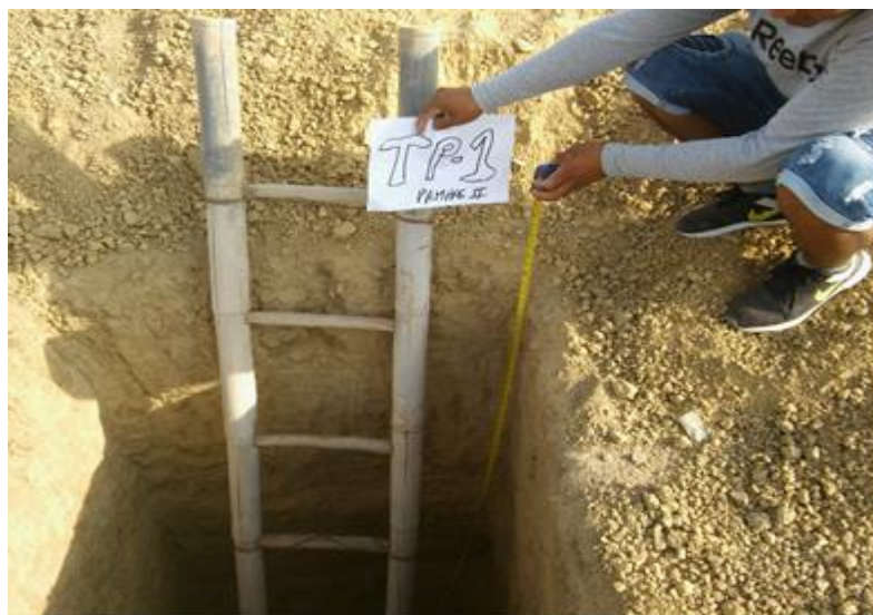
Figura N° 05: Calicata de 1.50 m de profundidad N° 1
