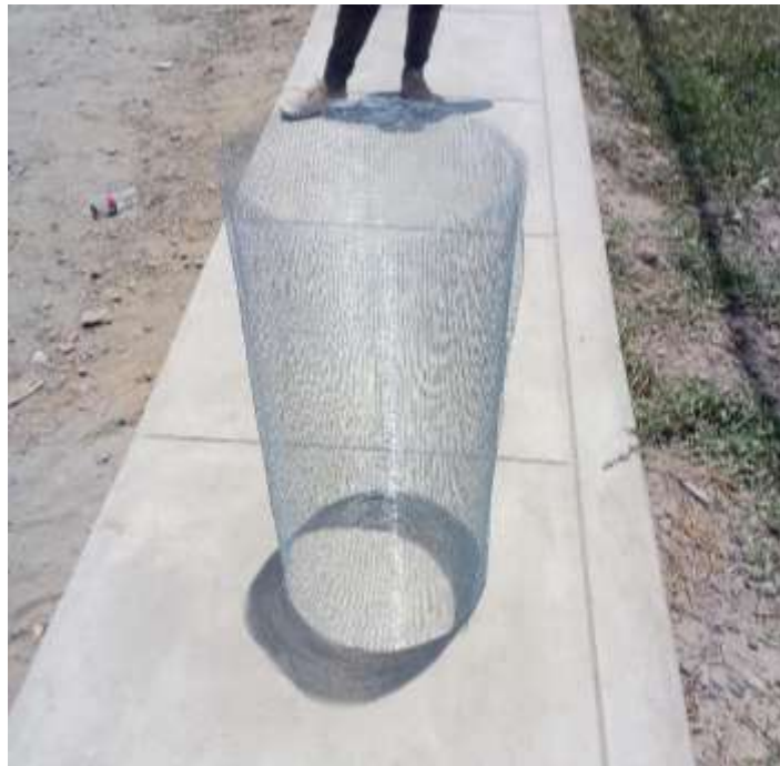
Foto 6.- Se utilizó una malla metálica y se le dio forma de un cilindro de 0.2 m de radio, el cual sirvió para la formación de los pozos a tierra de 0.2 m de radio, el cual fue rellenado con tierra de chacra en su interior.
