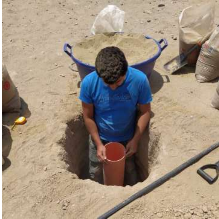
Foto 5.- Se utilizó un tubo de 0.1 m de radio para la formación de los pozos a tierra de 0.1 m de radio, el cual fue rellenado con tierra de chacra en su interior.
