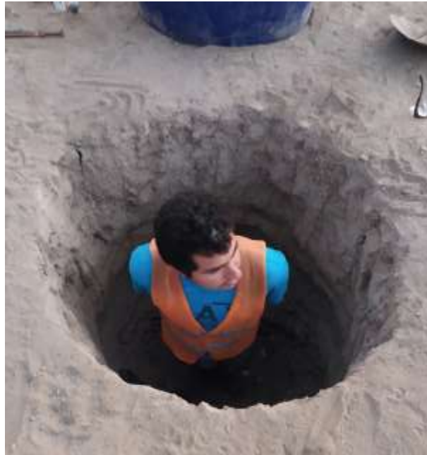
Foto 7.- Pozo a tierra de 0.5 m de radio, profundidad máxima de 1.7 m, relleno con 1.204 m 3 de tierra de chacra y en el cual se enterró 1.2 m del electrodo de cobre.
