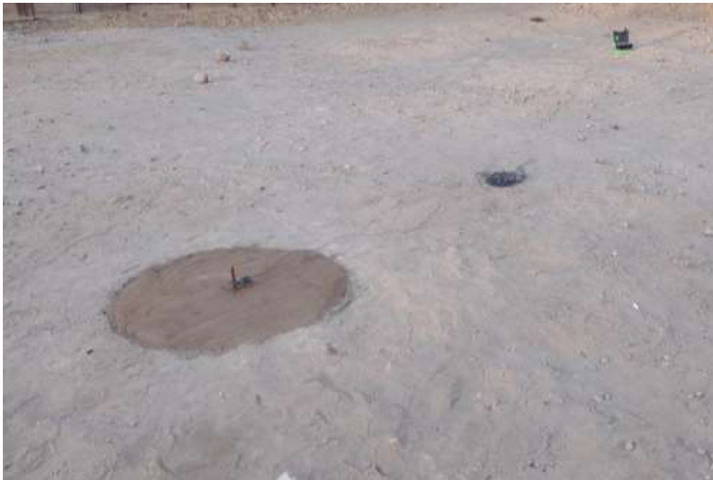
Foto 8.- Medición de la resistencia con el método del 62%, se utilizó un teluometro de marca Megabras el cual fue calibrado el 23.10.2020 en la empresa Unimetro.
