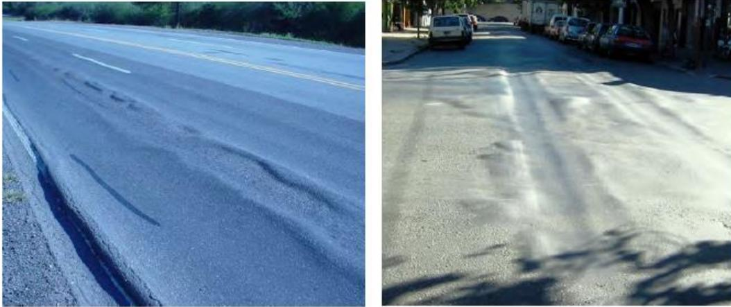
*Figura 2:* Deformaciones permanentes en mezclas asfálticas, p.7
