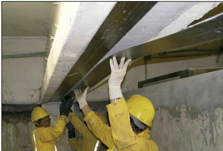
Figura 12 Refuerzo con láminas en vigas.
