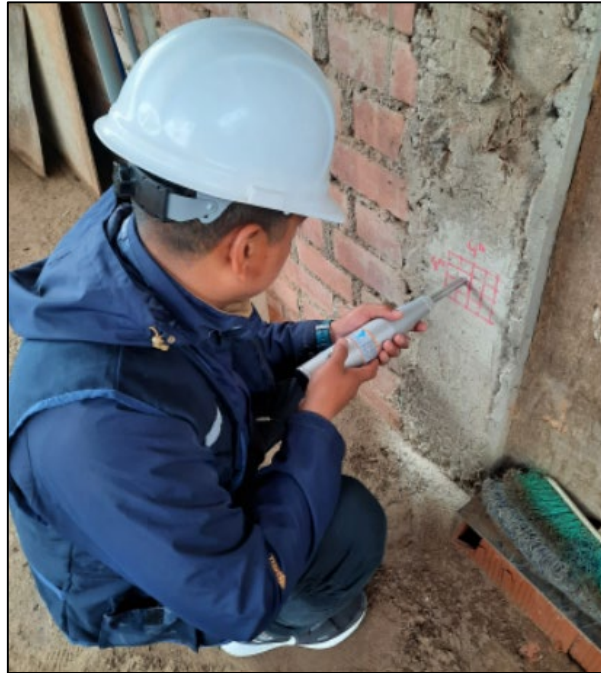
Figura 56. Ensayo de Esclerómetro en campo.
