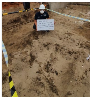
Figura 6. Vista Fotográfica de Campo - Calicatas.
