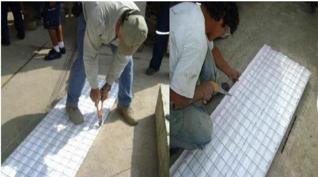
*Figura 28.* Imagen real en obra del corte de paneles, para la unión de los mismos, cuando se unen continuamente.
