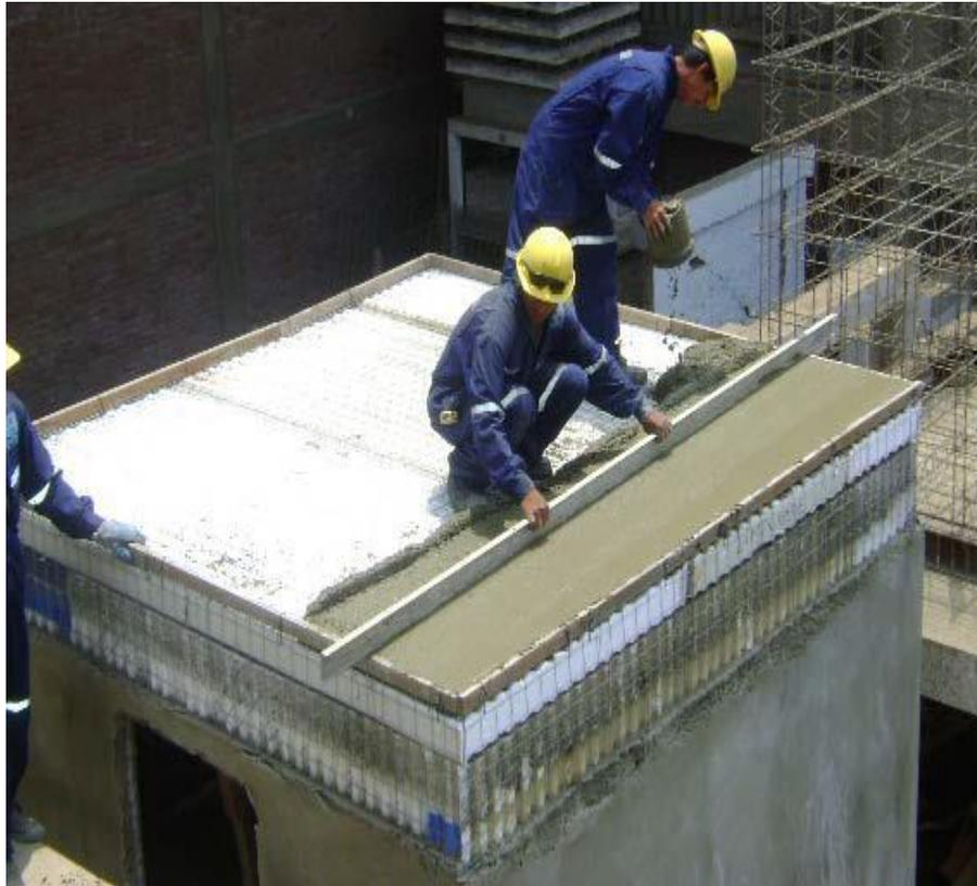
Figura 32. Etapa 04. Imagen real en obra de vaciado de concreto en el panel losa exterior.
