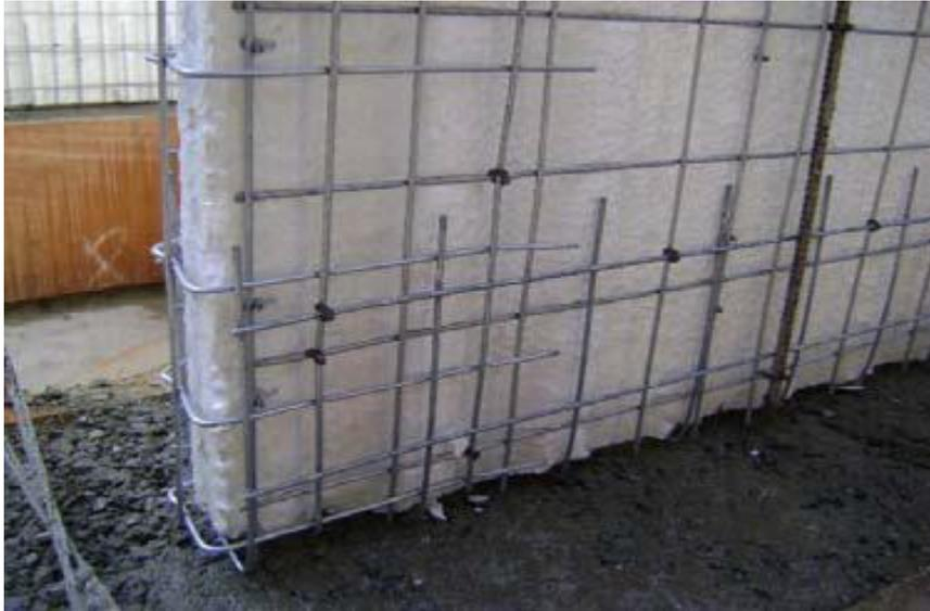
*Figura 27.* Imagen real en obra del amarre de la malla tipo U, en los paneles que pueden quedar expuestos.
