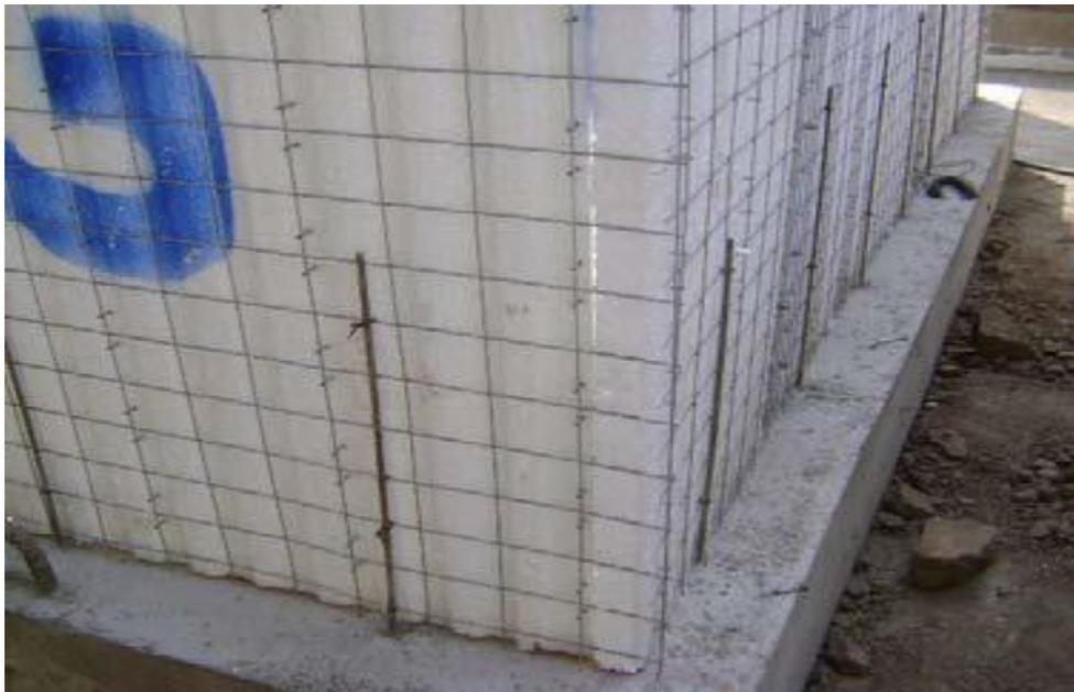
Figura 24. Etapa 02. Imagen real en obra del montaje de los paneles a la cimentación, anclada con varillas de acero de 6 mm de diámetro de 0.90m, amarradas al panel por alambres lisos n° 16.
