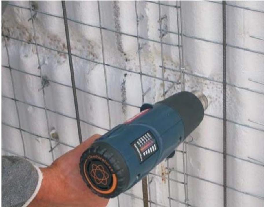
*Figura 29.* Imagen real en obra del corte de paneles, para las instalaciones respectivas, por medio de un soplete de aire caliente.
