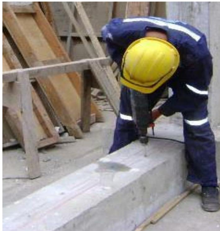
*Figura 22.* Etapa 01: Perforaciones en la cimentación, para el anclaje del acero corrugado de 6mm de diámetro @ 0.20 en forma de zigzag, para el montaje de paneles.
