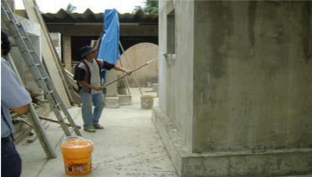
Figura 31. Etapa 04. Imagen real en obra del curado del mortero.
