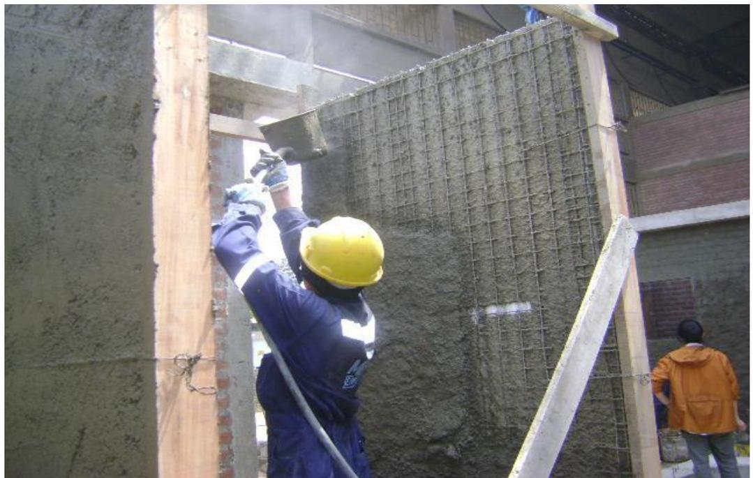
*Figura 30.* Etapa 04. Imagen real en obra de recubrimiento con mortero proyectado.
