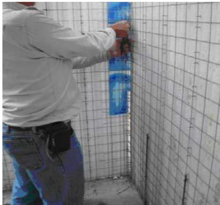
*Figura 26.* Imagen real en obra del amarre de la malla angular en la unión de los paneles perpendiculares, por medio de alambre liso n° 16.
