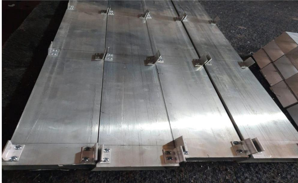
**Figura 27.** Armado de molde con espigas.
