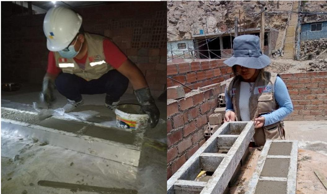
**Figura 35.** Reposo de mezcla y desmoldado.
