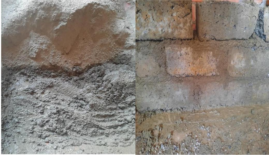
**Figura 60.** Mortero para asentamiento de ladrillos para elaboración de murete.
