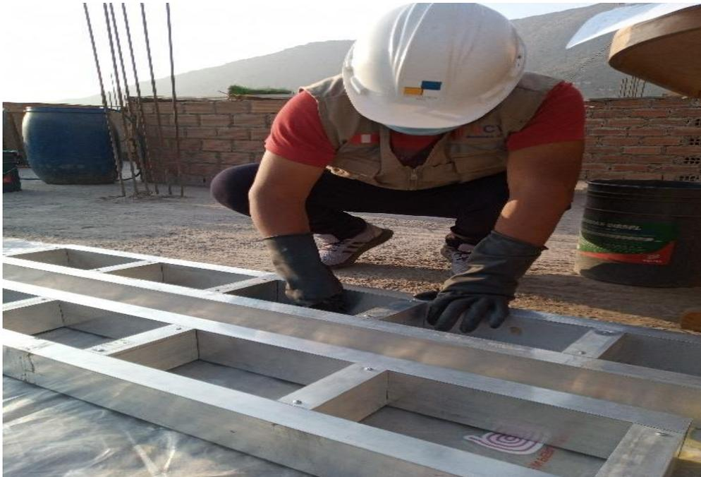
*Figura 33. Colocación de desmoldante.*
