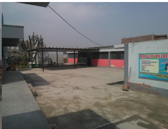
Foto 2. Aulas con muros de albañilería y techo de canalones.
