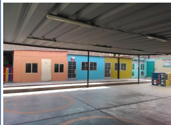
Foto 1. Aulas de material prefabricado.
