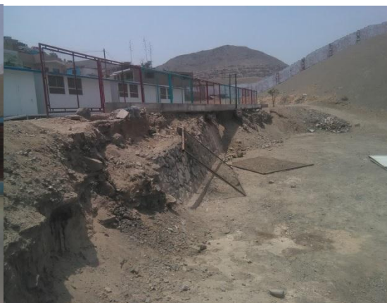
Foto 2. Instalacion aulas prefabricadas
