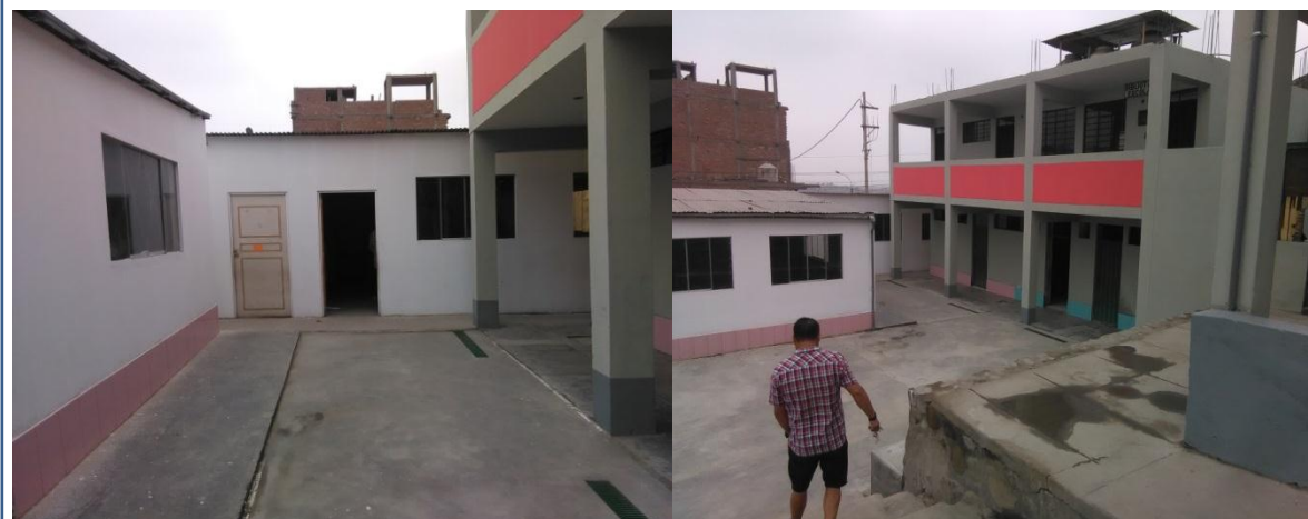
Foto 3. Aulas de material prefabricado con techos de canelones.
