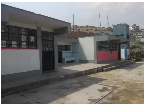
Foto 3. Aulas y Baño de concreto con muros de albañilería.
