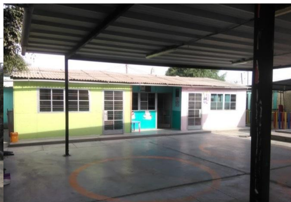
Foto 1. Aulas y dirección de material prefabricado.
