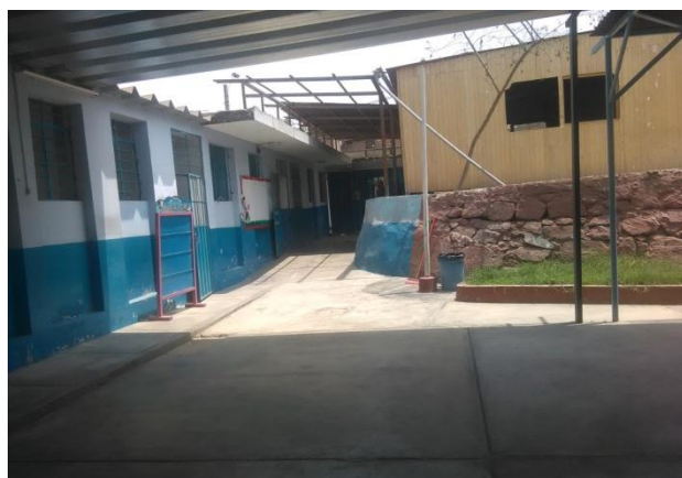
Foto 3. Dirección con techo aligerado y aulas con muros de albañilería y techo de canalones.
