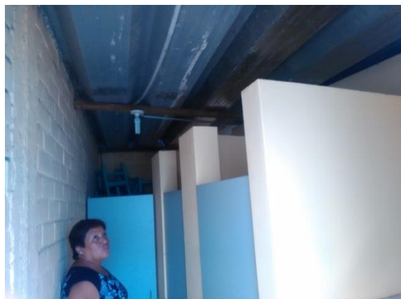
Foto 5. Baños con paredes de albañilería y techos de canelones.
