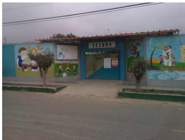
Foto 1. Fachada e ingreso de la IE .
