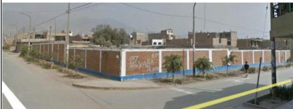
Foto 38: Cerco perimétrico entre calle K y calle 3
