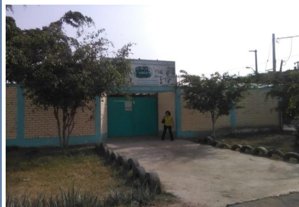
Foto 1. Fachada e ingreso a la IE .
