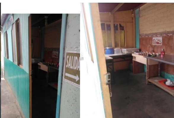
Foto 2. Área de cocina con material prefabricado.
