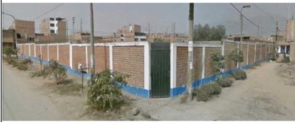
Figura 22. Vistas fotográficas de la infraestructura y equipamiento de la institución educativa inicial (IEI) 894
