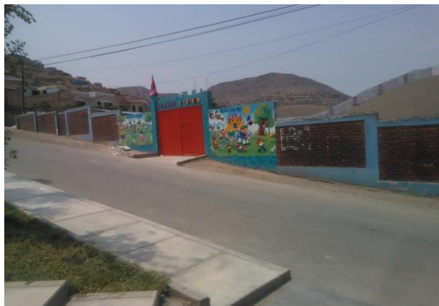
Foto 1. Cerco calle 3 s/n
