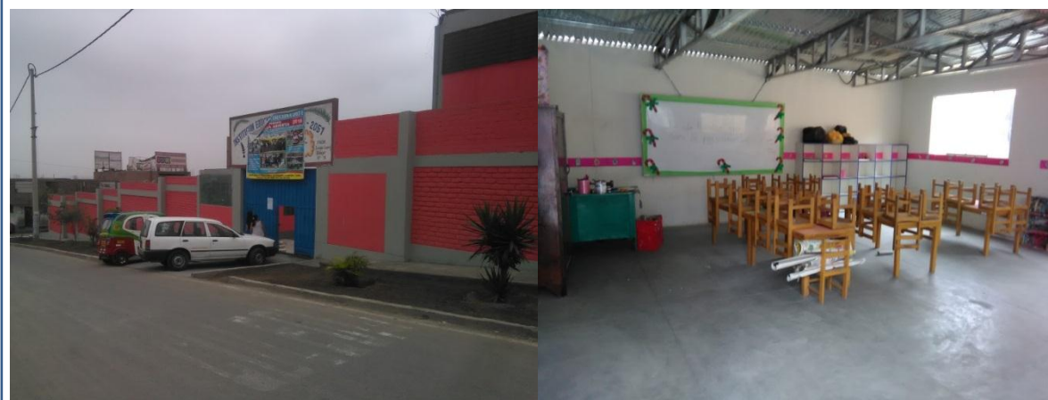
Foto 1. Fachada e ingreso a la IE .
