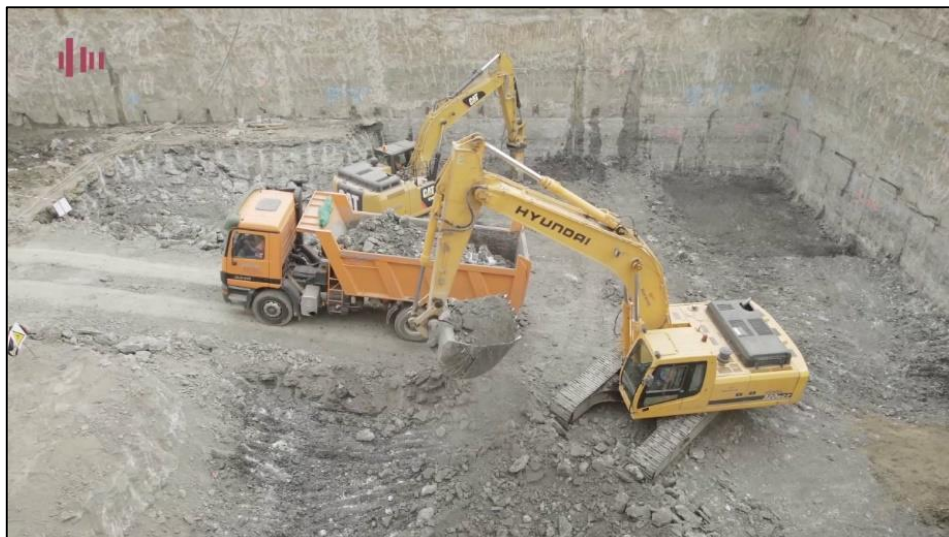
Figura 1: Movimiento de Tierras mediante excavadora
