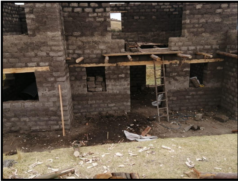
Figura 3. Evaluación del proceso constructivo en viviendas de adobe
