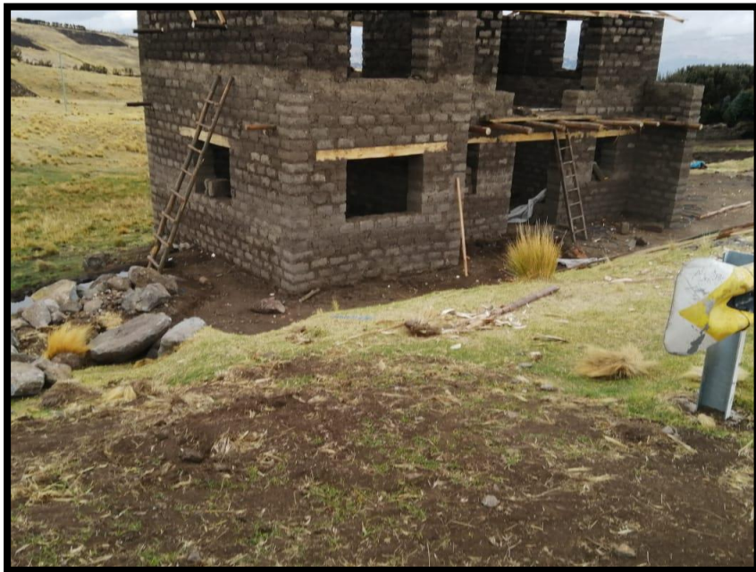
Figura 4. Vista frontal en construcción de vivienda de adobe
