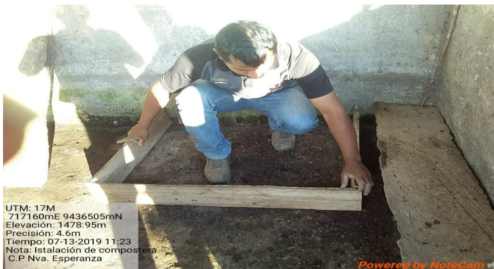
Acondicionamiento del área para la descomposición de la pulpa
