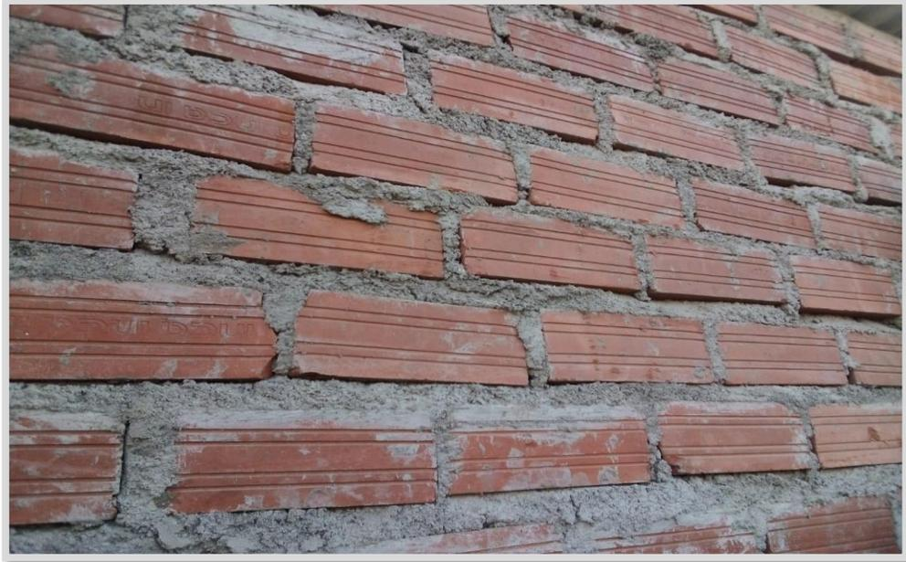
*Figura 4. Uso del mortero para pega de ladrillos.*
