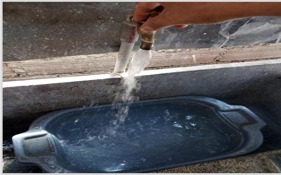
Figura 6. Agua potable para la mezcla del mortero.
