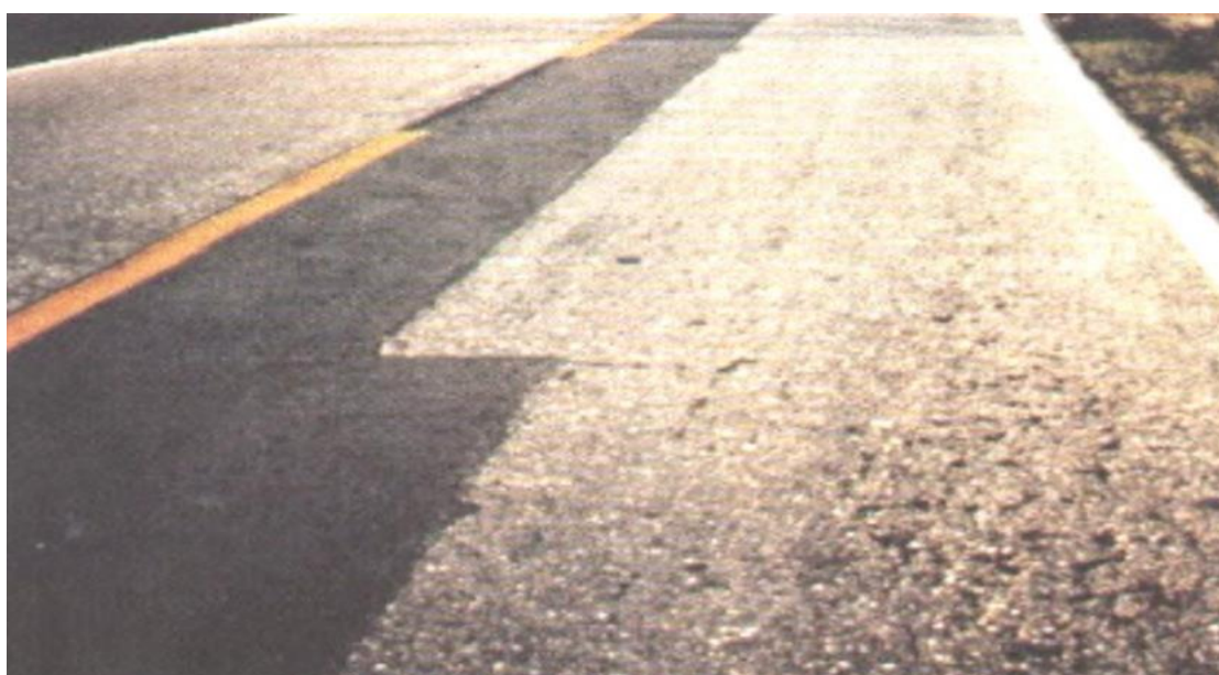
Gráfico. N° 8. Reparación o bacheo de deterioros
