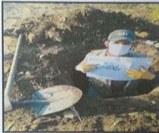
FOTOS N° 11 Y 12: Vista panorámica y Excavación manual de Calicata N° 06
