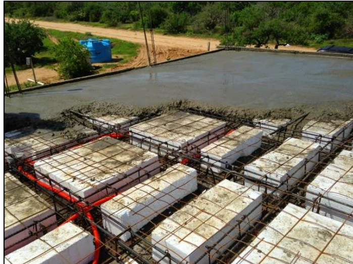
Figura 5. Construcción de losa aligerada en dos direcciones
