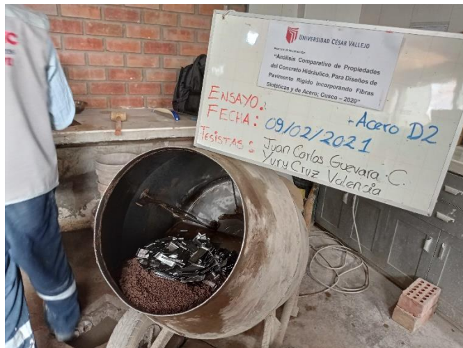
Preparación de la mezcla con la adición de la Fibra de Acero.
