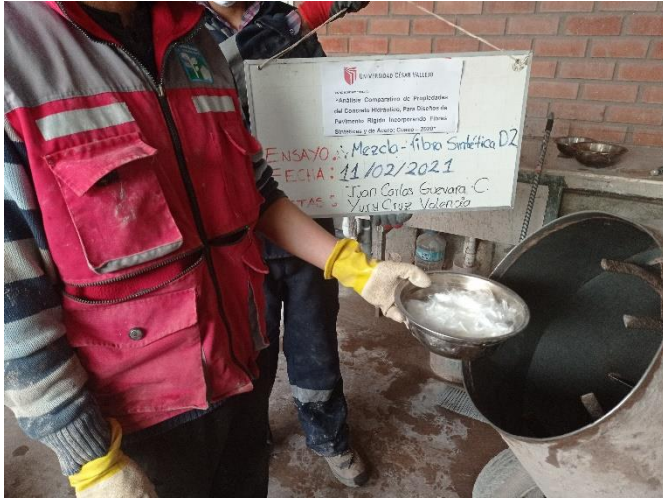
Preparación de la mezcla con la adición de la Fibra Sintética.
