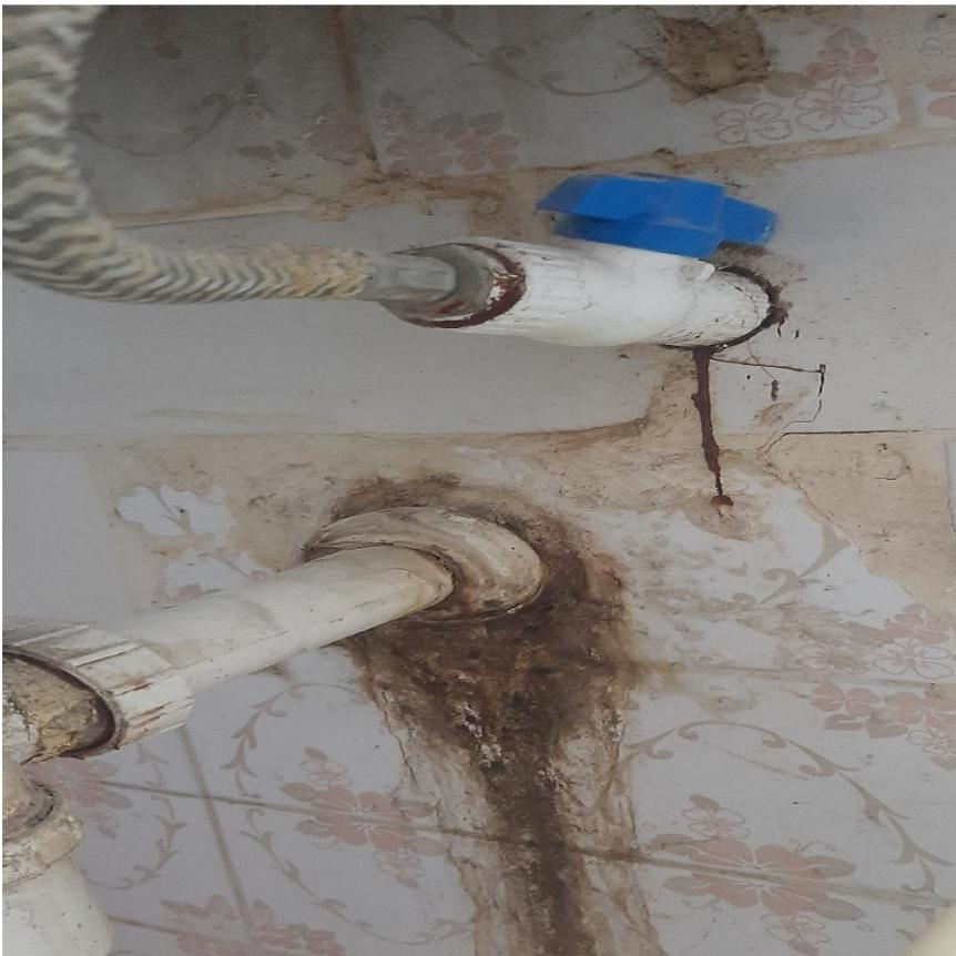
**Figura 2.** Fuga de agua en la instalación de agua y dentro de muro presentando filtración de adentro a fuera. (Fuente Propia).
