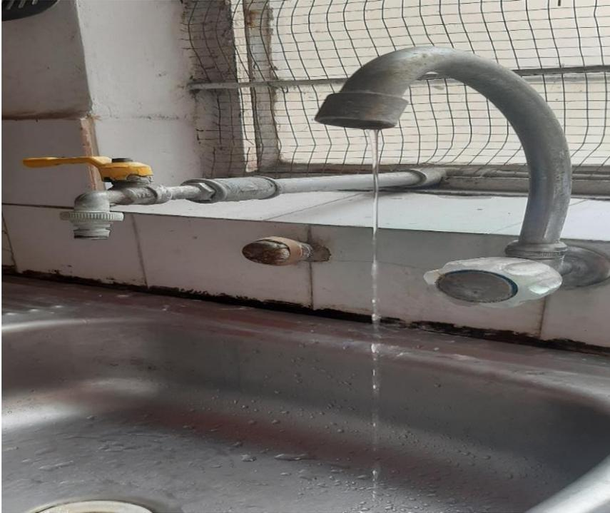
**Figura 1.** Cañería defectuosa con fuga de agua en la cocina del departamento N.º 4, segundo piso (Fuente propia).
