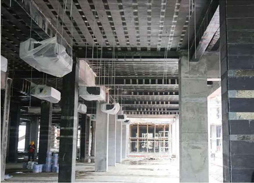
*Figura 42 Reforzamiento estructural con fibra de carbono viga, losa, columnas*
