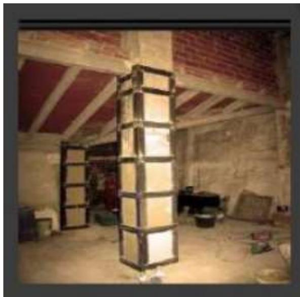
*Figura 36 Platinas metálicas*
