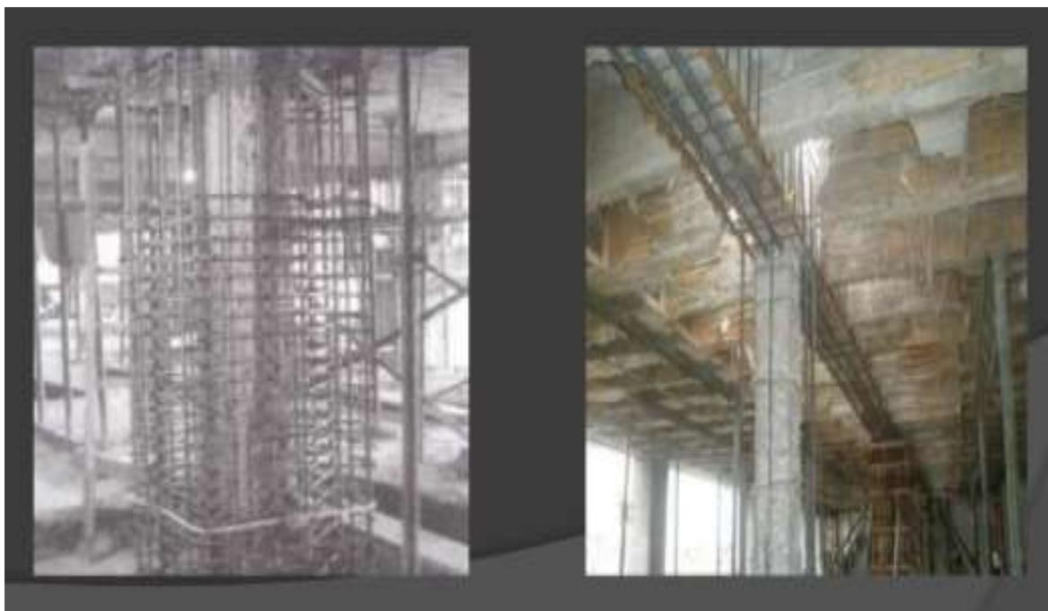
Figura 34 Encamisado en concreto reforzado
