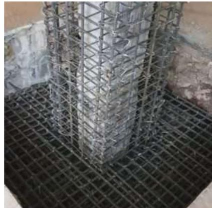
Figura 38 Encamisado a una zapata
