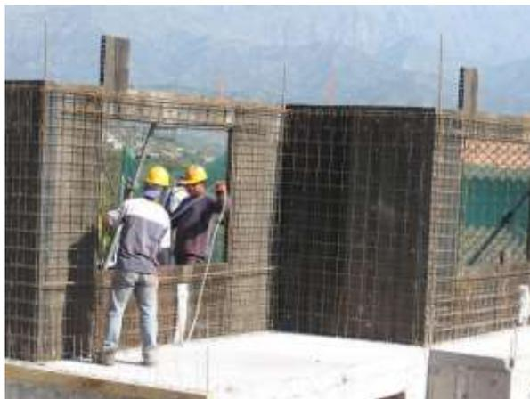
Figura 40 Reforzamiento con malla electrosoldada
