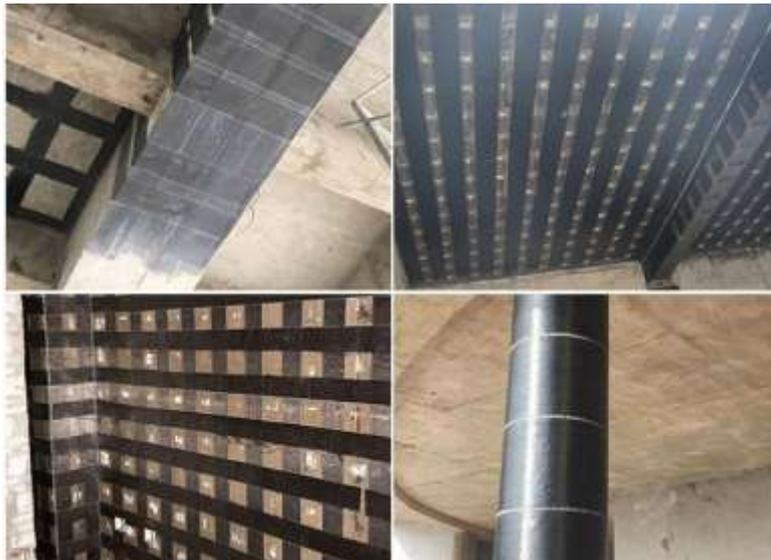
*Figura 43 Reforzamiento estructural con fibra de carbono viga, losa, muro, columna circular*
