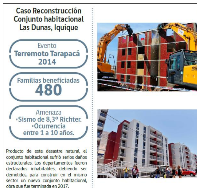
Figura 1. Reconstrucción del Conjunto habitacional Las Dunas que fue dañado por el sismo del año 2014. (UNIDAD DE COORDINACIÓN DE RECONSTRUCCIÓN, 2018 pág. 27) 5
