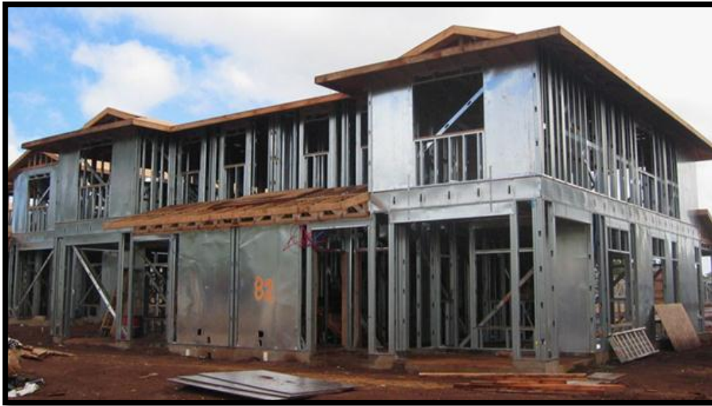
Figura 15: Vivienda de Steel Framing con revestimiento de acero
