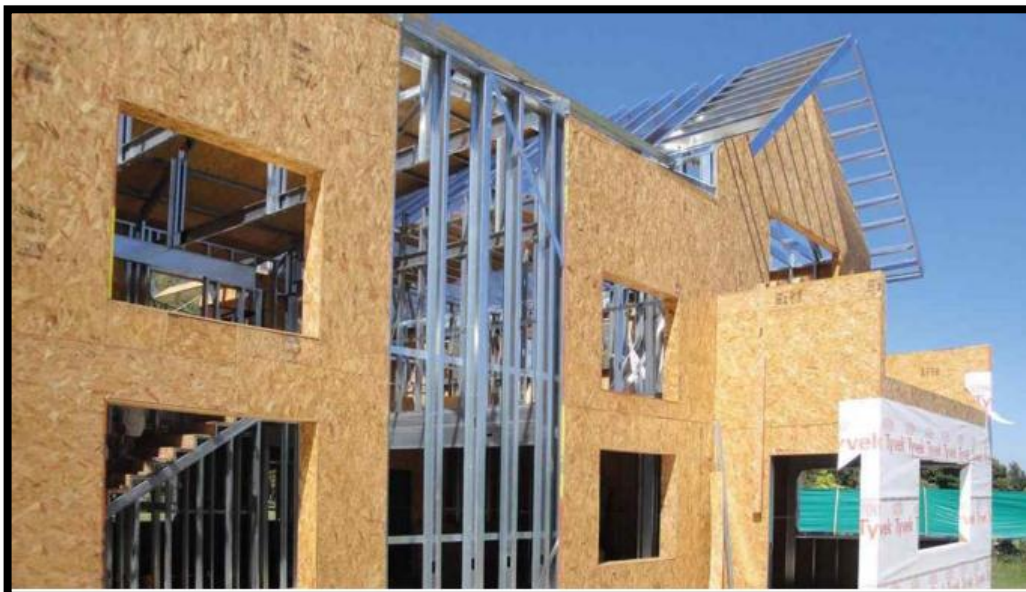
Figura 16: Vivienda de Steel Framing con revestimiento de placa OSB
