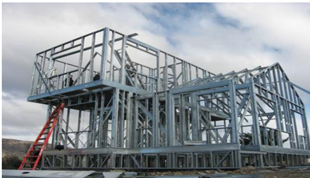
Figura 9: Vivienda en Steel Framing
