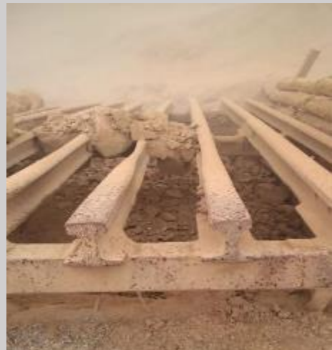
Colocación de parilla clasificadora en el ingreso de la tolva.
