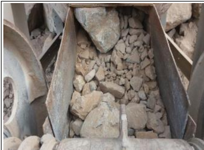
Paralización de la planta por atascamiento trituradora primaria. Piedra mayor de 40 cm ingresó a la tolva.
