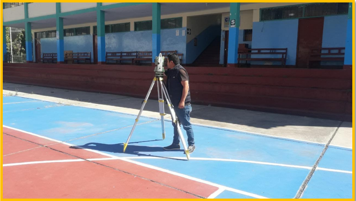
Fotografía 6. Vista del levantamiento topográfico de la institución Educativa 9 de diciembre.
