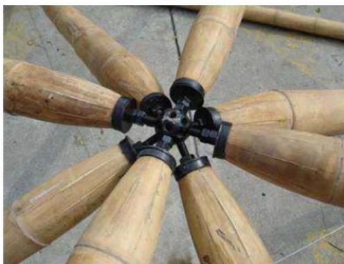
Figura 06. Unión cónica con esfera, J. Stamm
