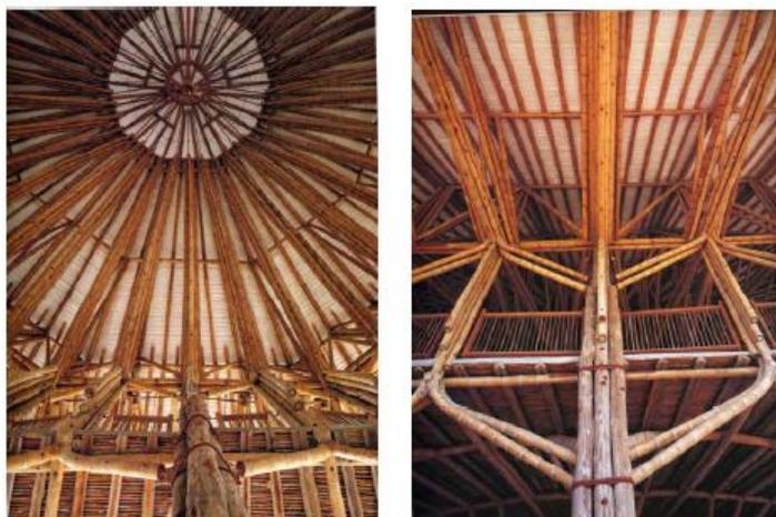
Figura 10: Detalle interior cubierta del pabellón y de columna en madera alisado
