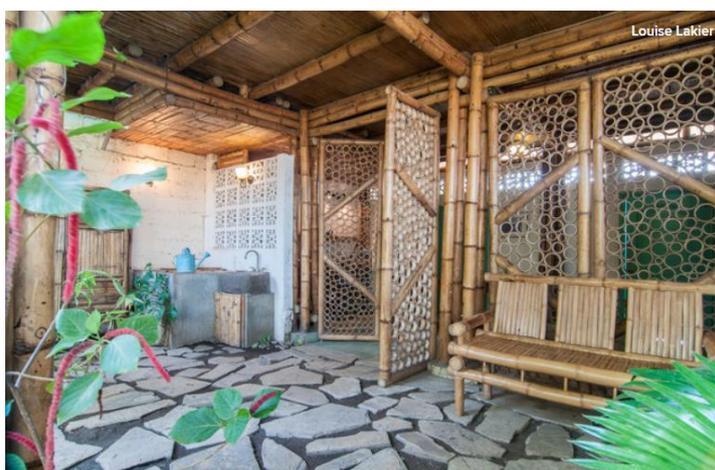
Figura 17. Las esteras de bambú para el techo ayudan a absorber el calor y enfriar el espacio.
