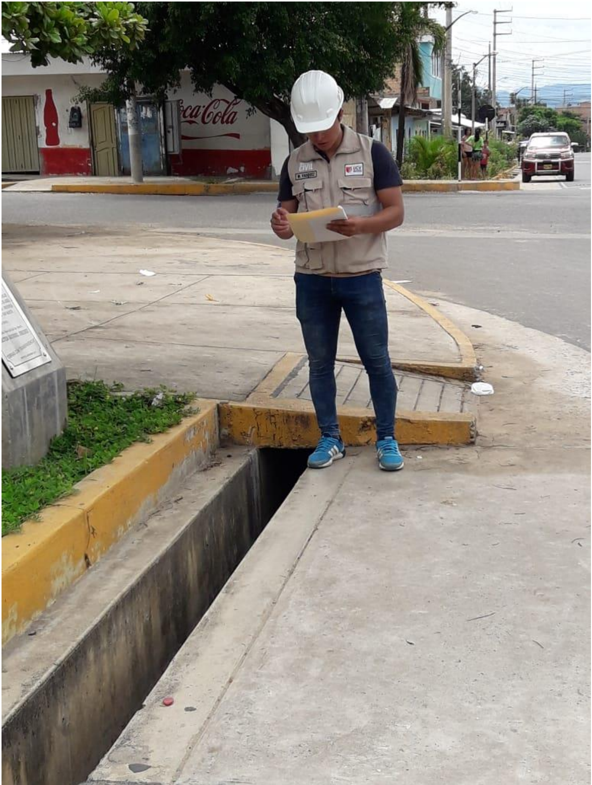
Figura 3: evaluando el estado de las obras de drenaje.
