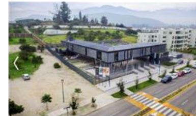
Figura: FACHADA DEL CENTRO CULTURAL EL TRANQUE Fuente: JUAN FRANCISCO VARGAS
