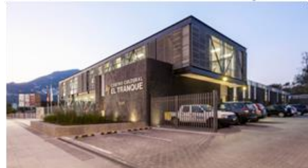
Figura: FACHADA DEL CENTRO CULTURAL EL TRANQUE Fuente: JUAN FRANCISCO VARGAS
