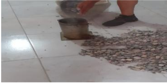
Colocación del agregado grueso.
