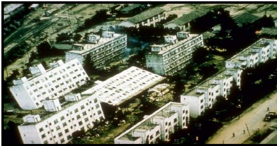
Figura 2: Licuación de suelo a causa del terremoto ocurrido en Niigata en 1964.
