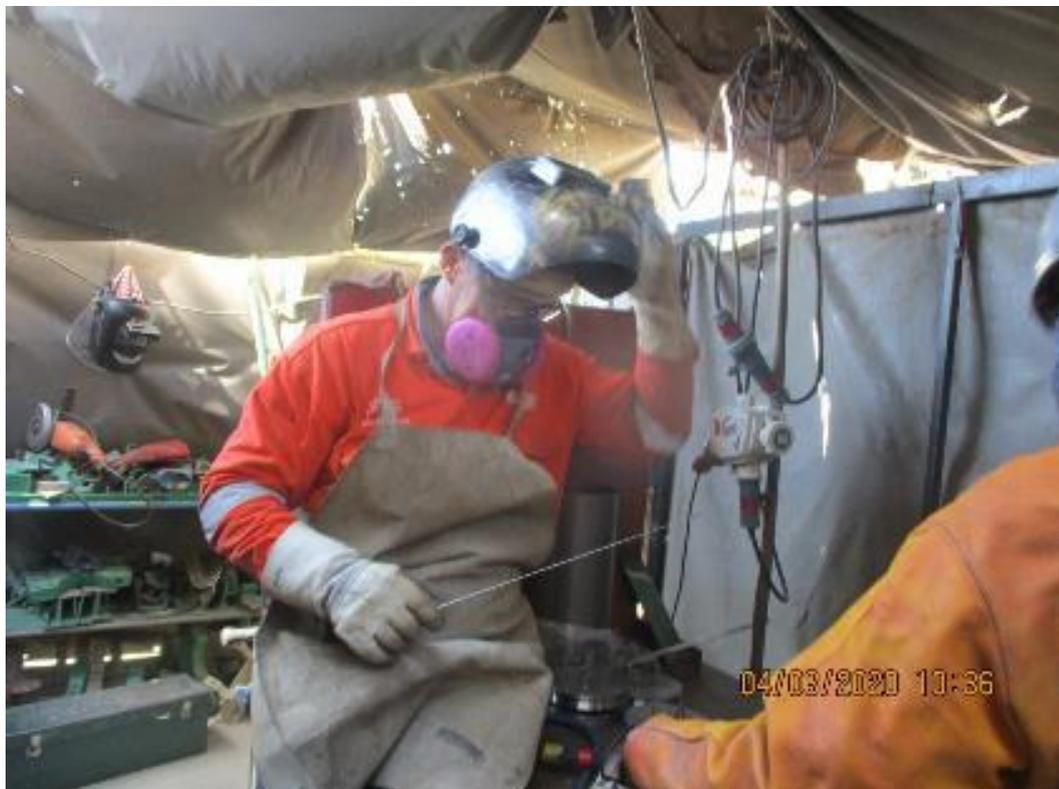
Figura 16. Soldadura con electrodo (proceso SMAW)
