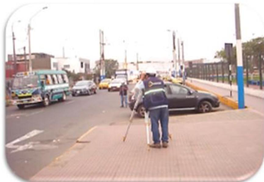
*Foto N°1 Se aprecia al operador de equipo estación total, realizando el levantamiento topográfico en la Av. Miguel Grau.*
