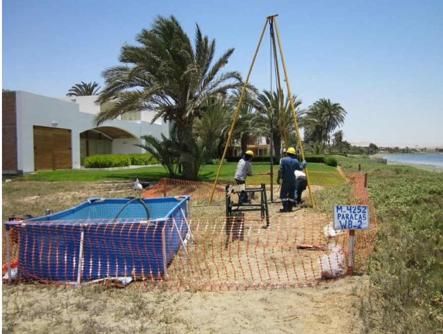
Gráfico 10. Equipo de Perforación Instalado
