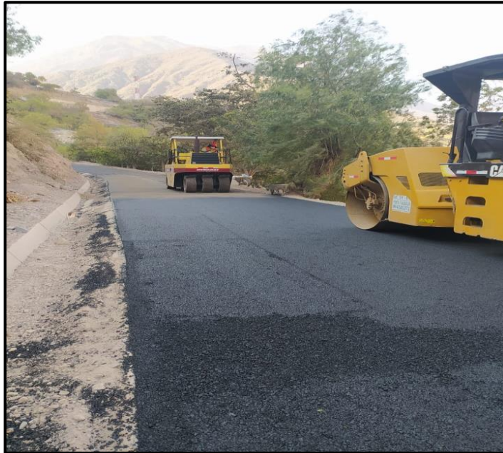
Figura 53: Compactación de carpeta asfáltica
