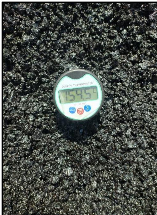
Figura 54: Control de temperatura del asfalto.
