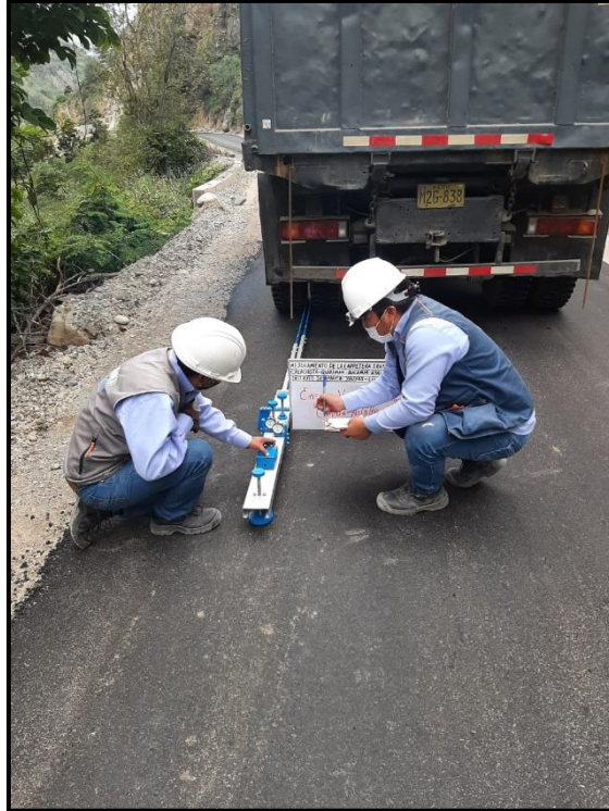
Figura 63: Pruebas de deflectometría a nivel carpeta asfáltica.
