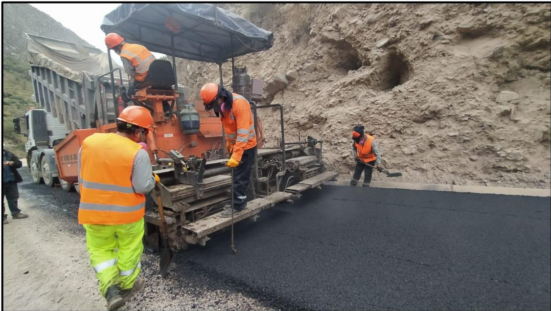
Figura 52: Colocación de carpeta asfáltica
