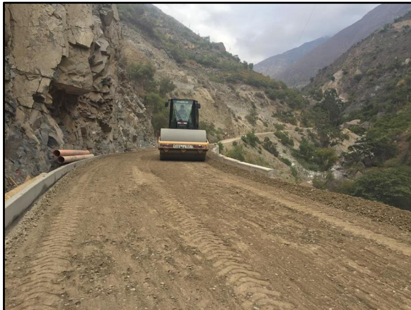
Figura 50: Compactación de las capas estructurales del pavimento.
