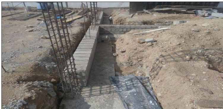
Figura 13 Cimentación corrida terminada
