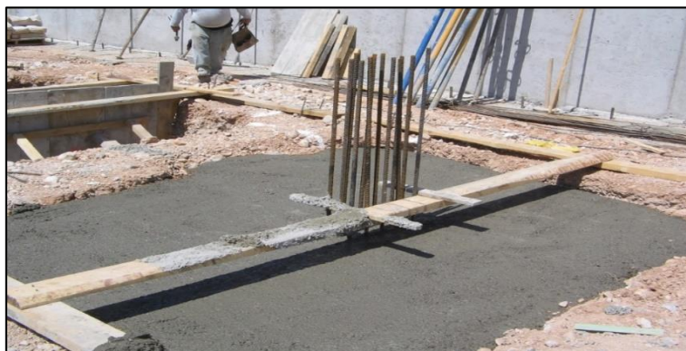
Figura 14 Cimentación tipo zapata terminada
