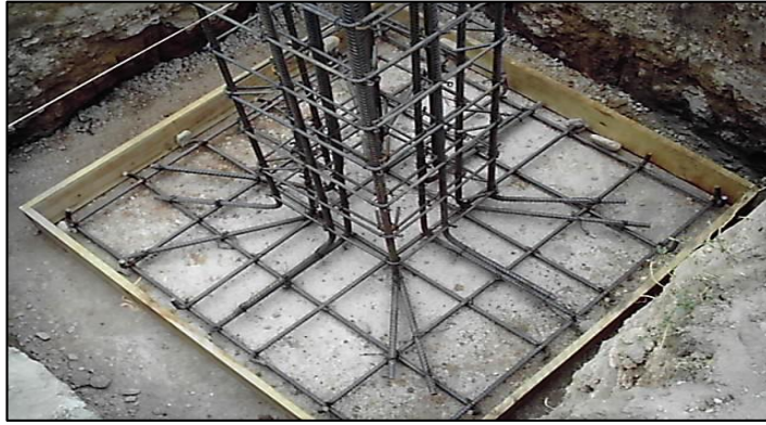
Figura 12 Detalle de encofrado cimentación tipo zapata
