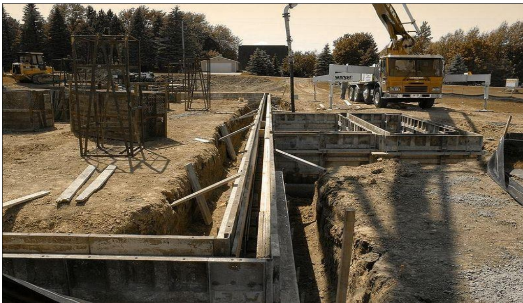
Figura 11 Detalle de encofrado cimentación corrida
