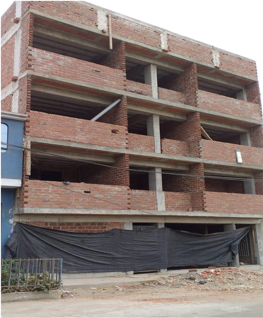
Construcción con asesoramiento técnico, sistema aporricado
