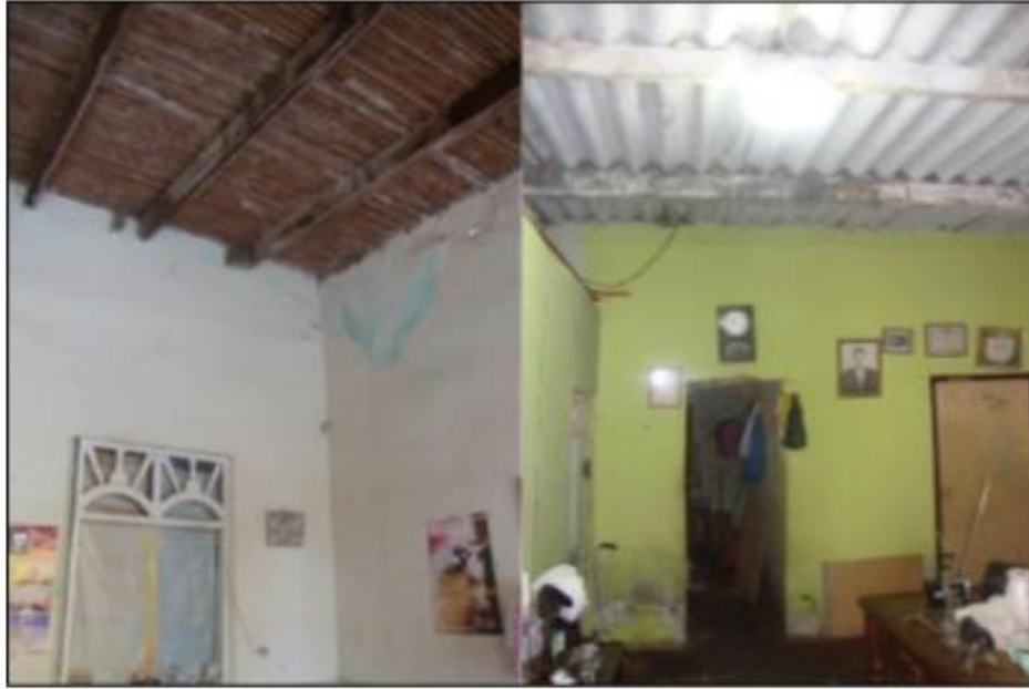
Figura 13. Edificaciones de albañilería con ausencia de diafragma rígido. Techo únicamente con cobertura liviana. Fuente: Elaboración propia
