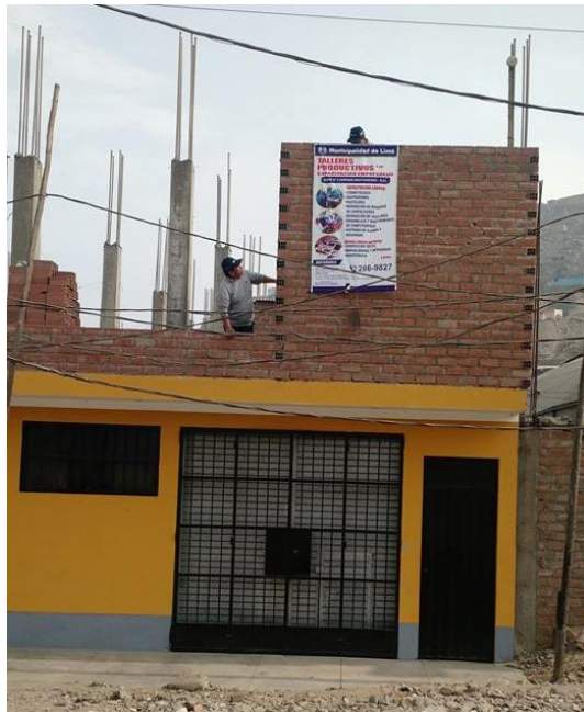
Figura 12. Edificación de albañilería confinada con ladrillo pandereta en muros portantes. Fuente: Elaboración propia
