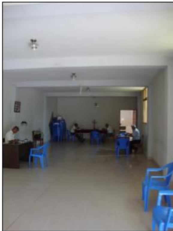
Figura 16. Edificaciones con muros portantes no arriostrados. Fuente: Elaboración propia
