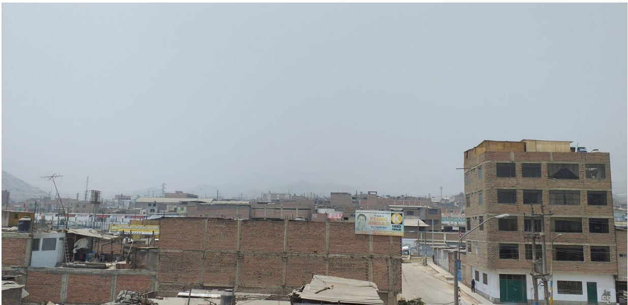
Construcciones autoconstruidas sin asesoramiento técnico.
