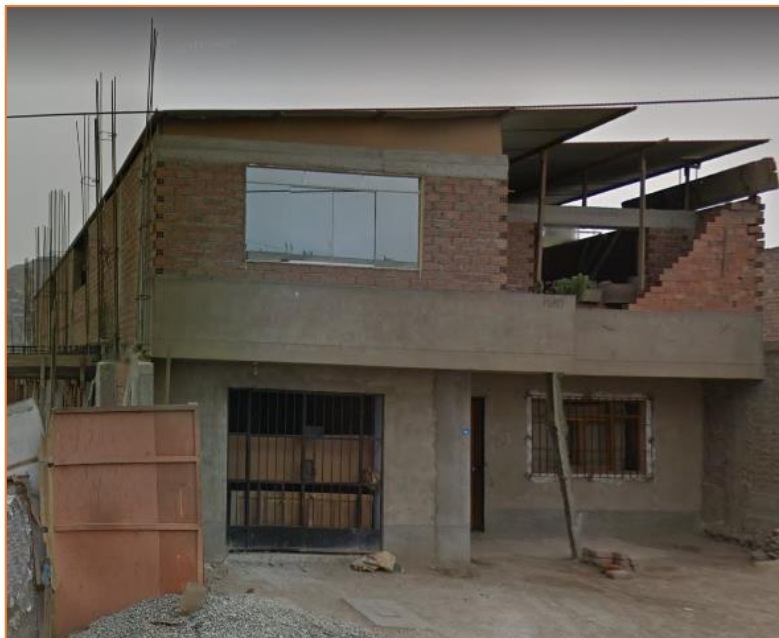
Figura 9. Nueva construcción de albañilería confinada, con asesoría técnica, según NTE E.070 Fuente: Elaboración propia
