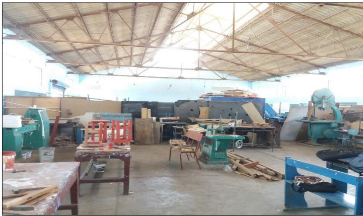
Figura 5. I.E Antenor Orrego, mobiliarios en mal estado en el aula de taller de carpintería
