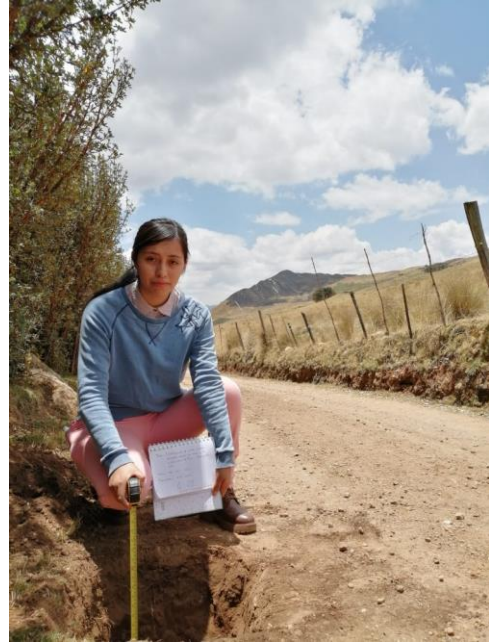
Fotografía 8. Realización de la calicata 02
