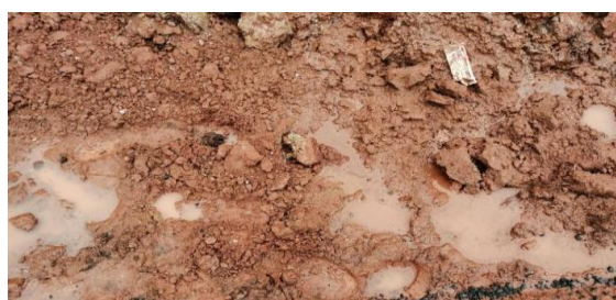
Figura 8. Suelo arcilloso de la carretera Cerro de Pasco – Yanahuanca
