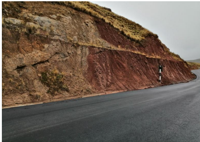
Figura 2. Talud de la carretera Cerro de Pasco – Yanahuanca
