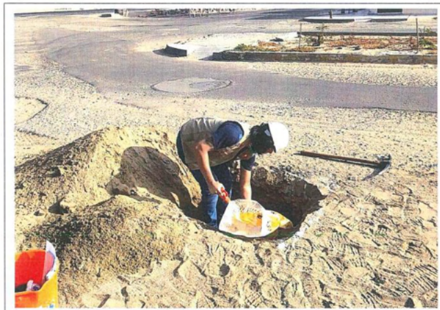
Foto N°06: Vista de la calicata C-03 en la avenida "A". De 0.00 a 0.04m de profundidad presencia de carpeta asfáltica deteriorada. De 0.04 a 0.29m de profundidad presencia de material afirmado conformado por grava limosa con arena (GM), compacto, seco de color beige claro y fino no plástico. De 0.29m a 1.50m de profundidad presencia de arena mal graduada (SP), medianamente compacto a compacto, seco de color beige y fino no plástico.
