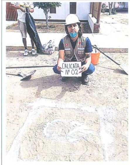
Foto N°03: Vista de ubicación de la calicata C-02 en la avenida "A"
