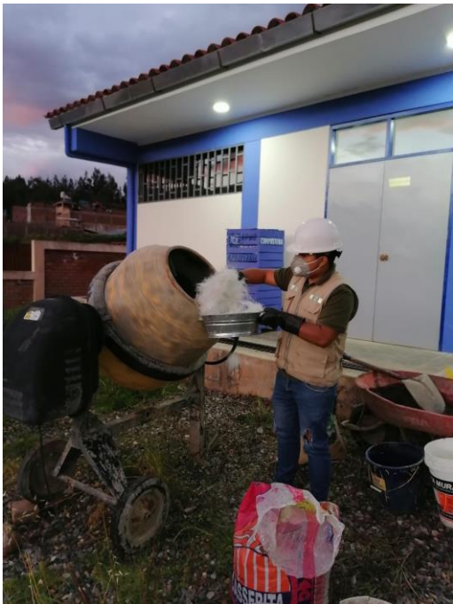
Imagen 45 y 46 . Realización de viguetas adicionando 0.075% de fibra de vidrio
