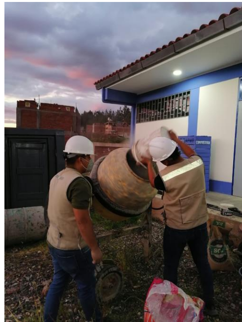
Imagen 45 y 46 . Realización de viguetas adicionando 0.075% de fibra de vidrio
