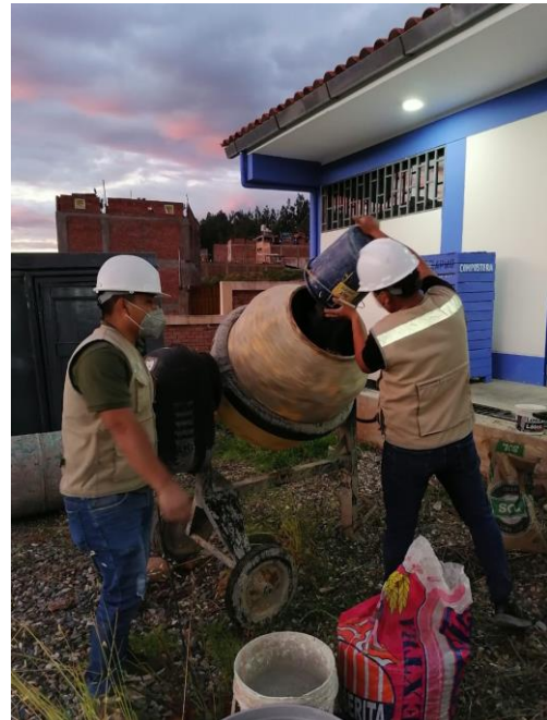
Imagen 43 y 44. Materiales para la realización de la vigueta con adición de 0.025% de fibra de vidrio.
