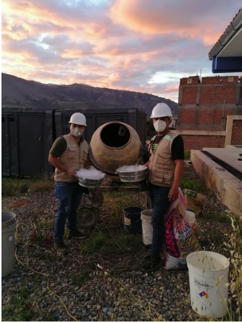
Imagen 43 y 44. Materiales para la realización de la vigueta con adición de 0.025% de fibra de vidrio.
