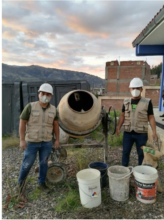
Imagen 40. Materiales para la realización de la vigueta patrón
