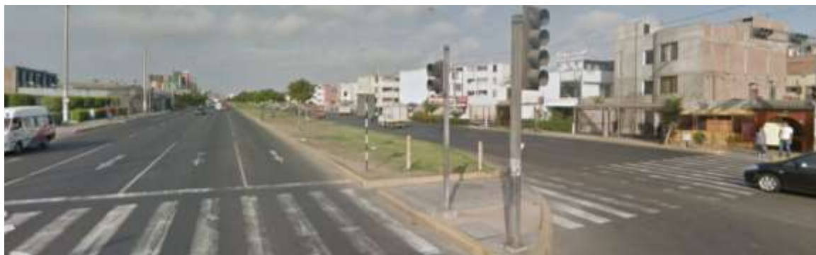
Fotografía 1: Intersección avenida Venezuela con calle Santa Bernardita - Vista Dirección Callao hacia Lima.
