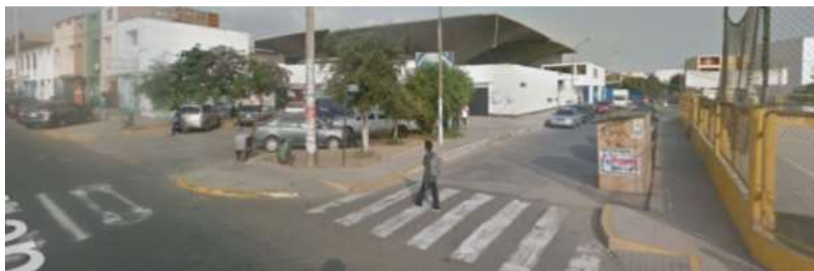
Fotografía 2: avenida Venezuela, ingreso a mercado Santa Rosa - Comercio Local, Se puede observar los accesos principales, y el estado en deterioro las edificaciones existentes, así como el mercado informal La Merced de color Azul.
