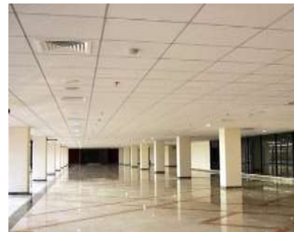
- Falso cielo raso en drywall
