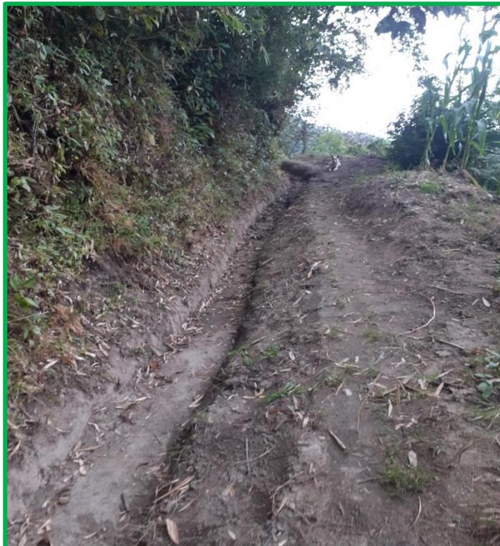
*Fotografía 17:* Canal de riego de terreno natural con secciones inadecuadas.
