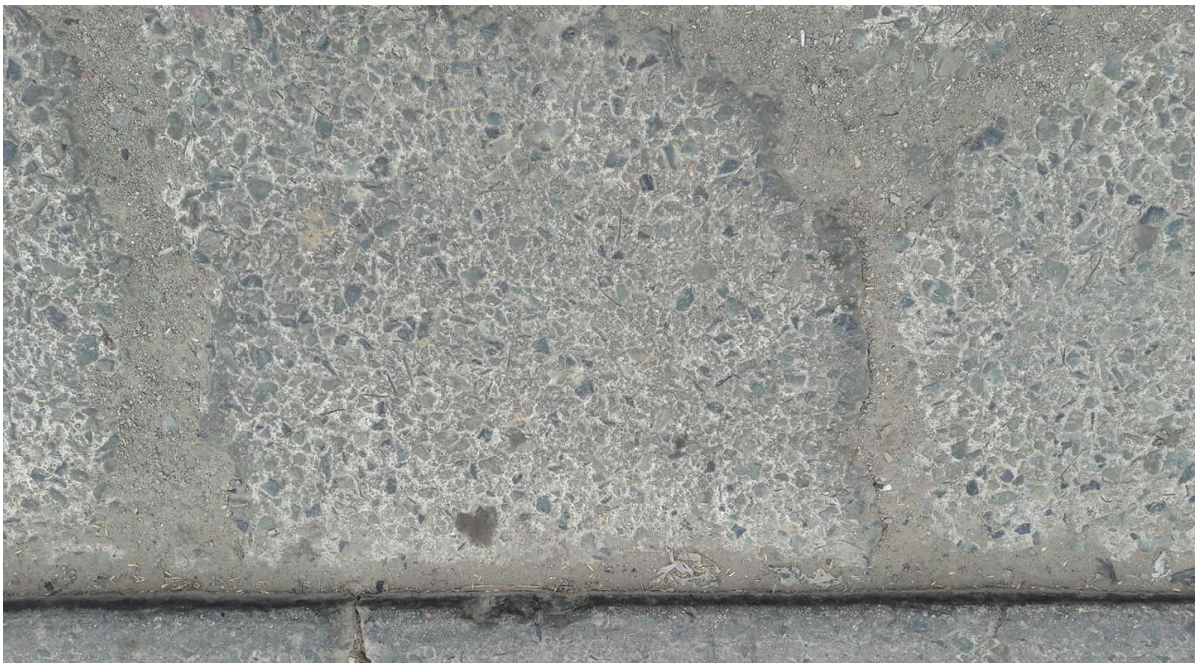
Figura N° 4: Pulimento de agregados
