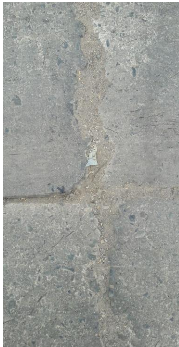
Figura N° 2: Fisura longitudinal
