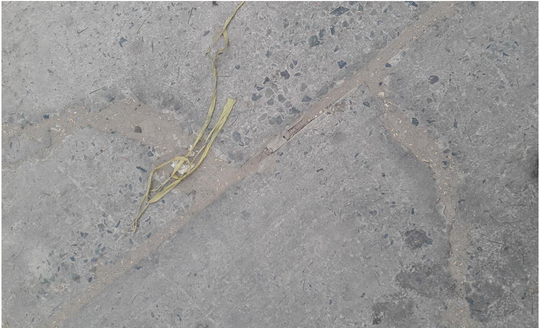
Figura N° 5: Fisura transversal
