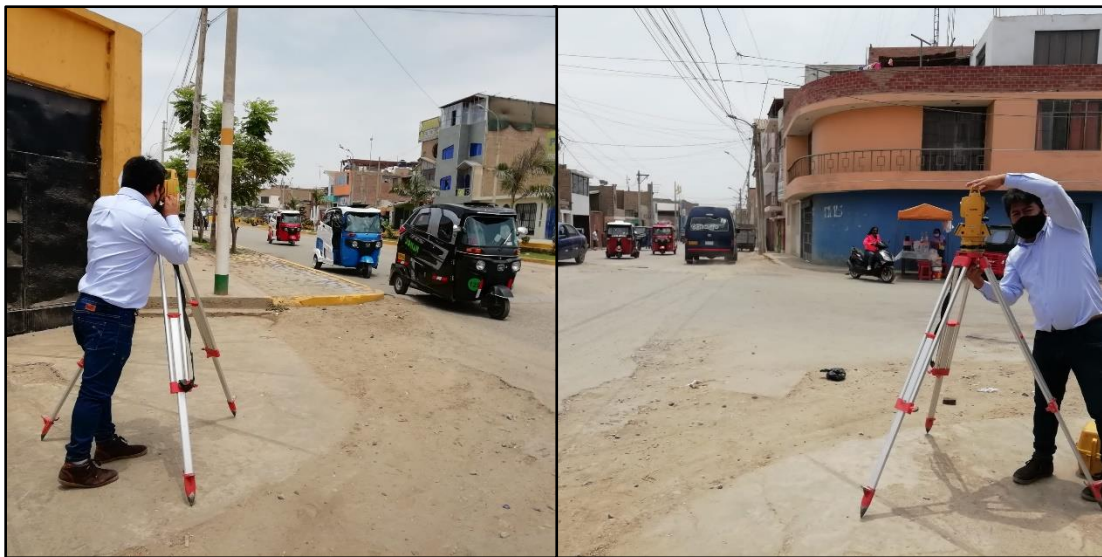
Figura 20: Inspección de las secciones transversales de las vías
