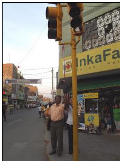
Figura 16: Semáforo vehicular en Avenida Ramos
