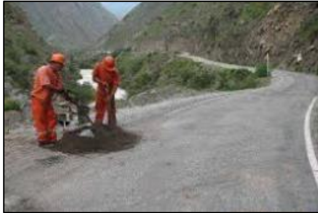
Figura 17: Mantenimiento de la carretera principal Fuente: Provias Nacional
