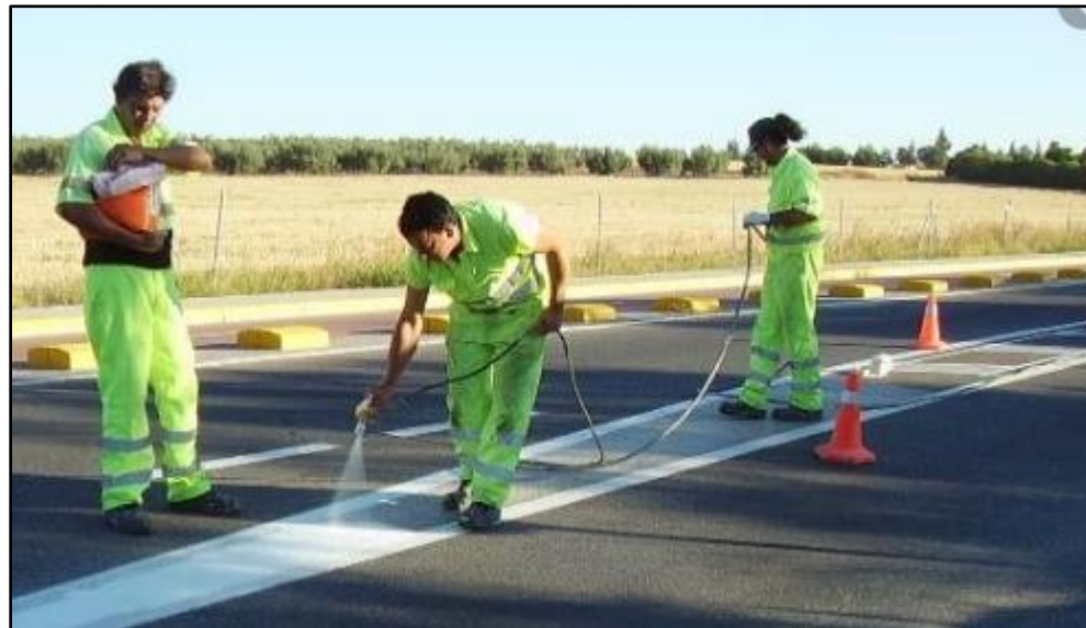
Figura 48. Señalización horizontal propuesta para carretera a Lunahuana
