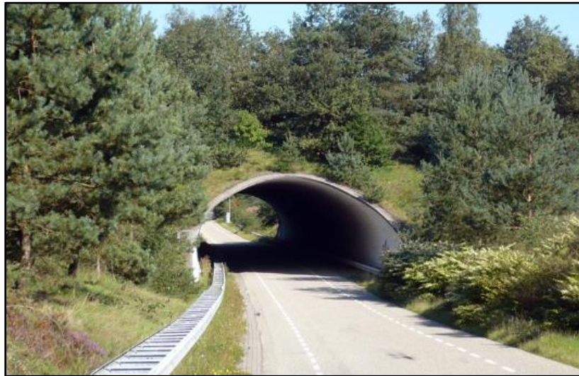
Figura 53. Estructura para pasos de fauna
