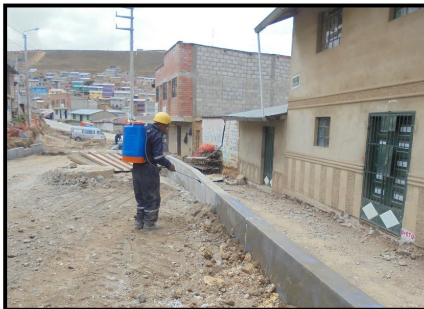
FIGURA N°22: CURADO DE CONCRETO CON ADITIVO EN SARDINEL.
