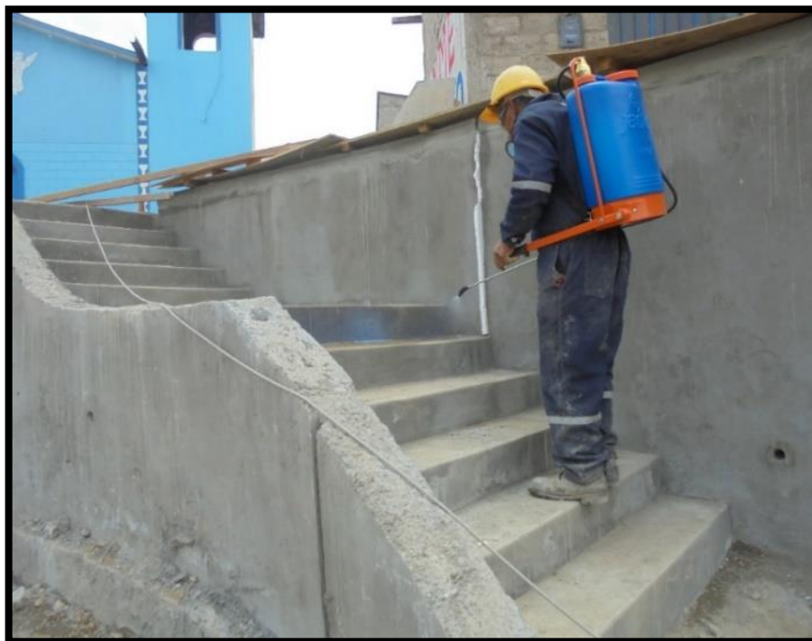
FIGURA N°18: CURADO DE CONCRETO CON ADITIVO EN GRADERÍA
