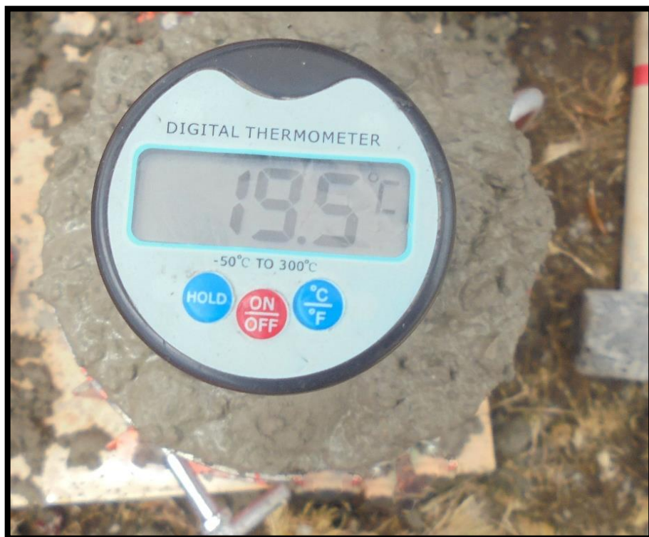
FIGURA N°06: TOMA DE TEMPERATURA AL CONCRETO.
