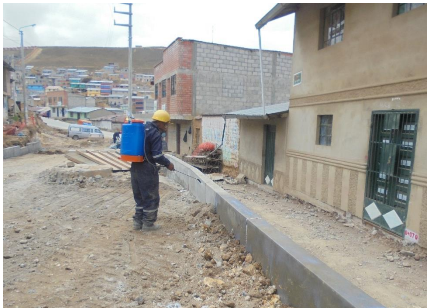
FIGURA N°37: Curado de concreto con aditivo en sardinel.
