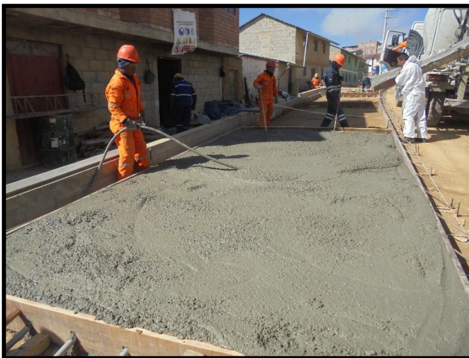
FIGURA N°17: VIBRADO DE CONCRETO EN PAVIMENTO.
