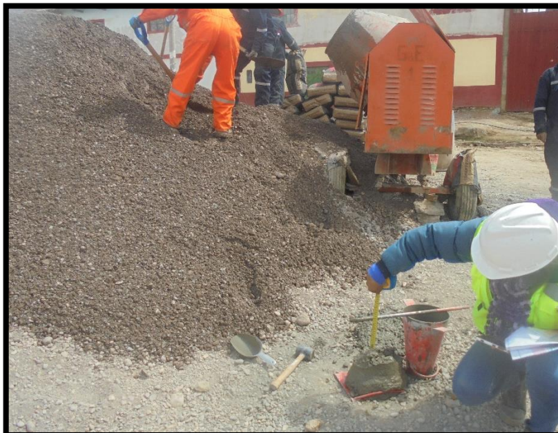
FIGURA N°10: MEDIDA DISTANCIA DEL DEZPLAZAMIENTO DE CONCRETO SLUMP=5"
