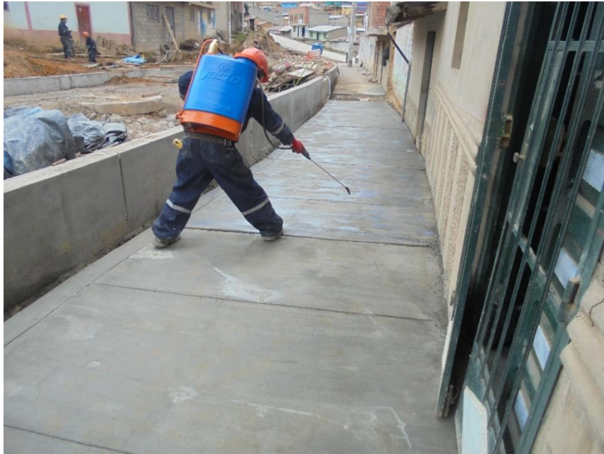
FIGURA N°36: Curado de concreto con aditivo en veredas.
