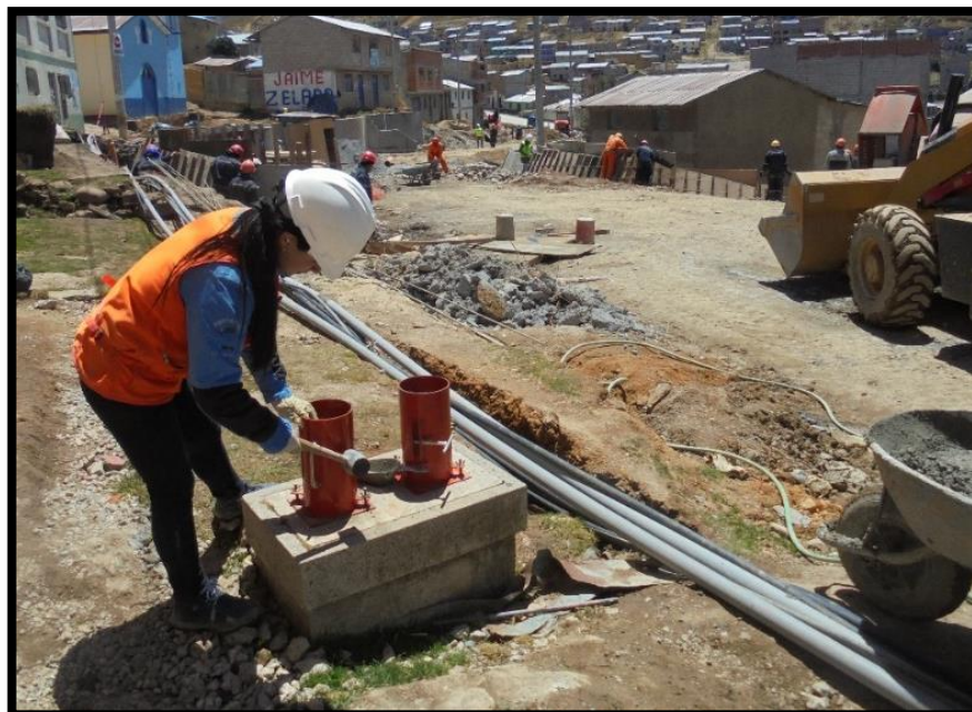
FIGURA N°11: REALIZACIÓN DE TESTIGOS GEMELOS DE CONCRETO ELABORADA EN OBRA
