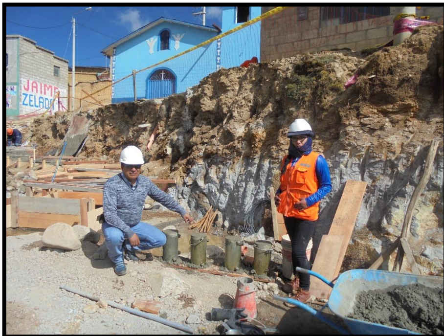
FIGURA N°13: REALIZACIÓN DE TESTIGOS GEMELOS DE CONCRETO PREMEZCLADO
