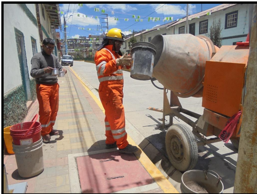
FIGURA N°04: AGREGADO FINO Y GRUESO AÑADIDO SEGÚN DISEÑO
