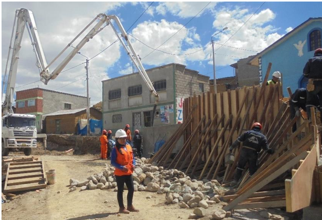
FIGURA N°08: Transporte de concreto por bombeo.
