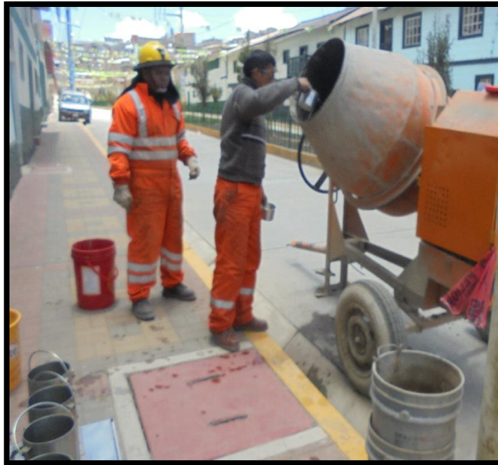
FIGURA N°04: AGREGADO FINO Y GRUESO AÑADIDO SEGÚN DISEÑO
