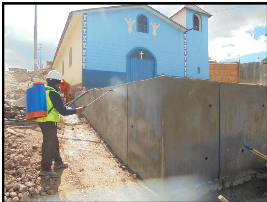
FIGURA N°20: CURADO DE CONCRETO CON ADITIVO EN MURO
