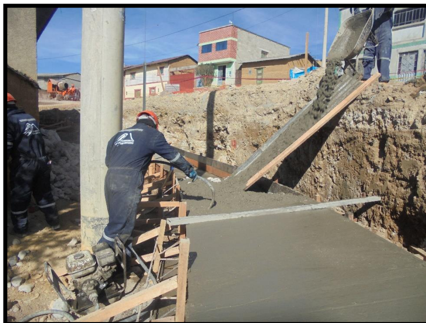
FIGURA N°16: VIBRADO DE CONCRETO EN ZAPATA DE MURO DE CONCRETO CICLÓPEO.
