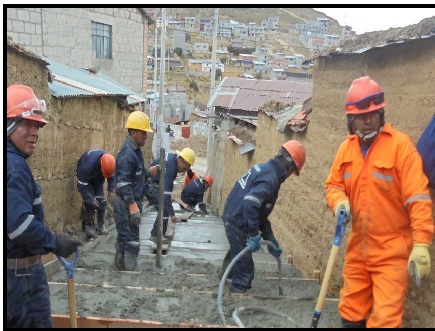
FIGURA N°15: VIBRADO DE CONCRETO EN VEREDA
