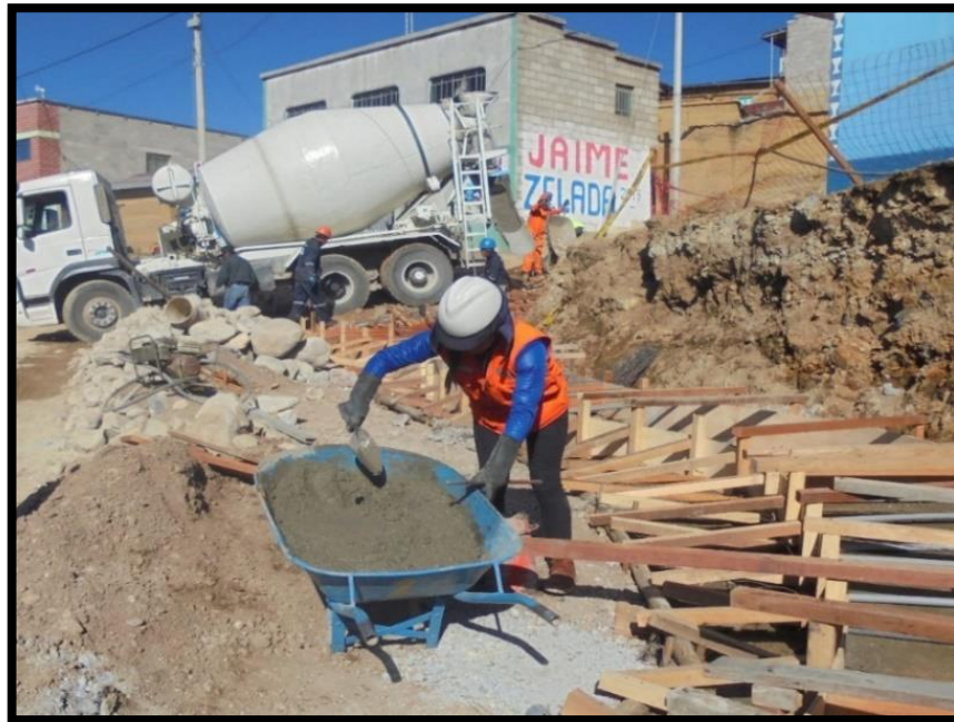
FIGURA N°07: ENSAYO DE CONO DE ABRAMS – REVENIMIENTO DE CONCRETO DE PLANTA - PREMEZCLADO
