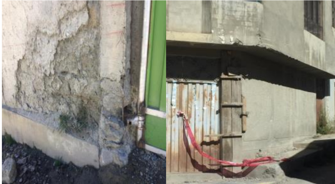
Figura 1. Fotografía de la realidad de estructuras en distrito de Ananea.
