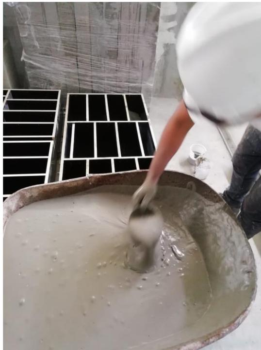
**Figura 38:** *Vaciado del concreto a los moldes.*
