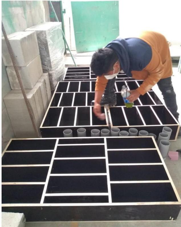
**Figura 35:** *Colocación de desmoldante.*
