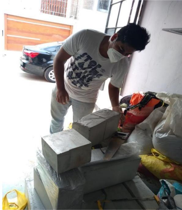
**Figura 47:** *Material cortado para elaborar los muretes.*
