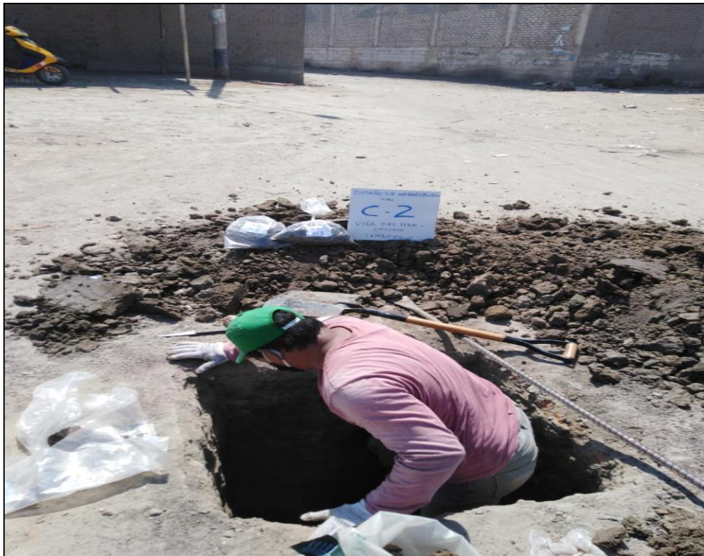
FOTO N° 02 - Vista a cielo abierto de la excavación en C - 02
