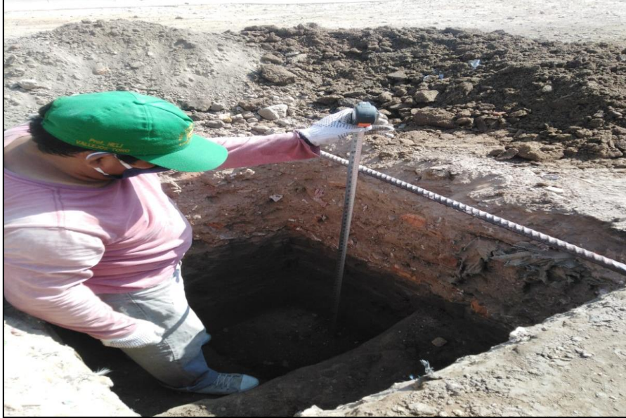
FOTO N° 01 - Vista a cielo abierto de la excavación y control de profundidad en C - 01
