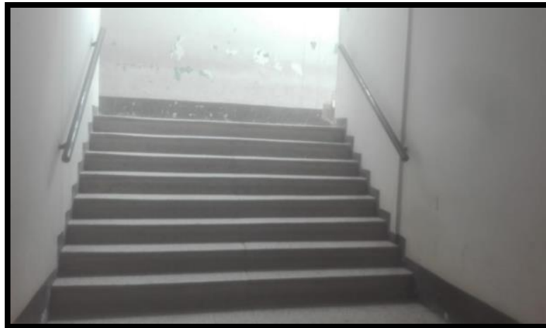
Figura 8. Acceso a Segundo Nivel de edificio
