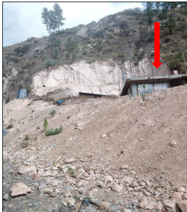
Figura 5. Vivienda construida al margen de la quebrada
