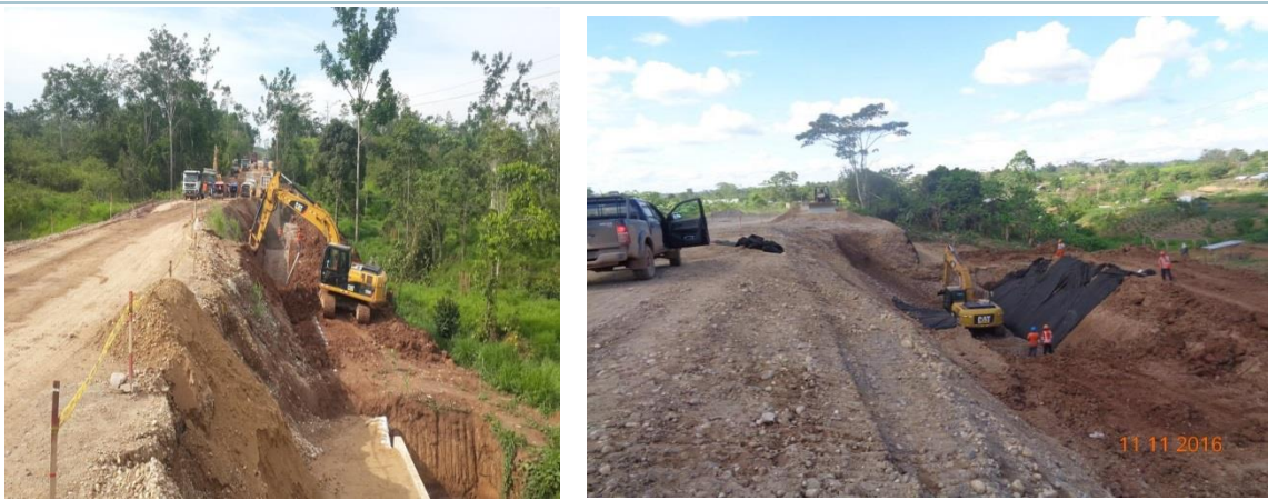
Foto N° 06: Ejecución de banquetas en relleno
