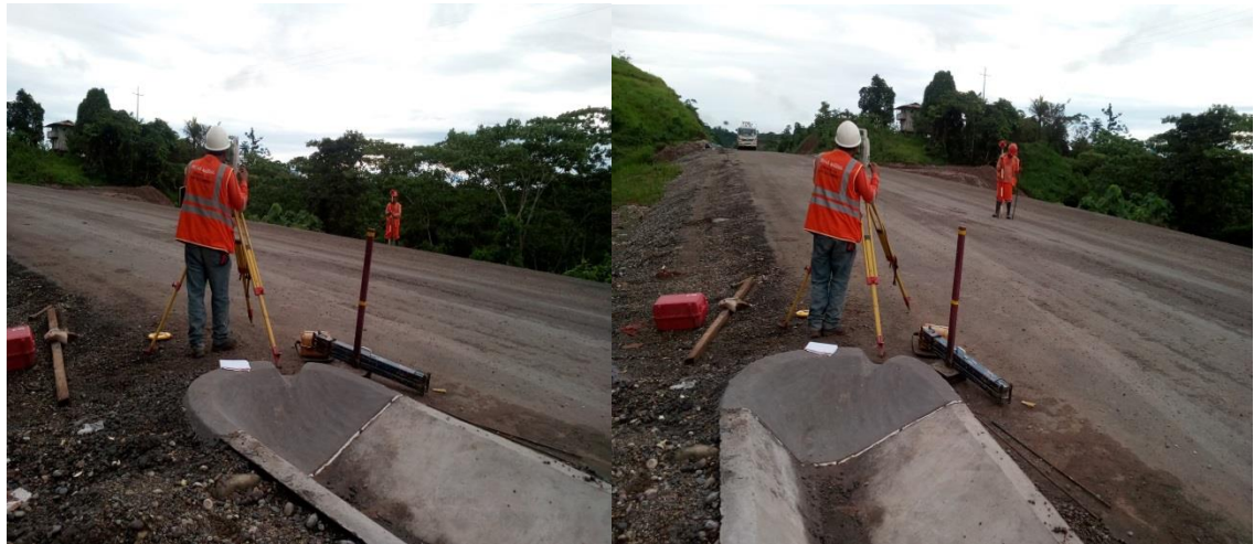
Foto N° 03: Trazo y replanteo de ejes toma de coordenadas de los puntos de control km:38+360 al 38+450
