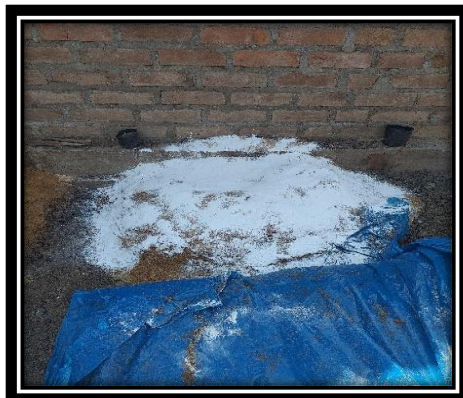
Fuente. Elaboración propia Figura 16. Aplicación de Cal.
