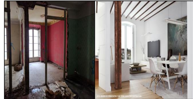
Rehabilitación arquitectónica interior de una edificación cultura antigua. Recuperado de: https://salineropampliega.com/2018/10/proyecto-de-rehabilitacion-de-edificio-de-viviendas.html
