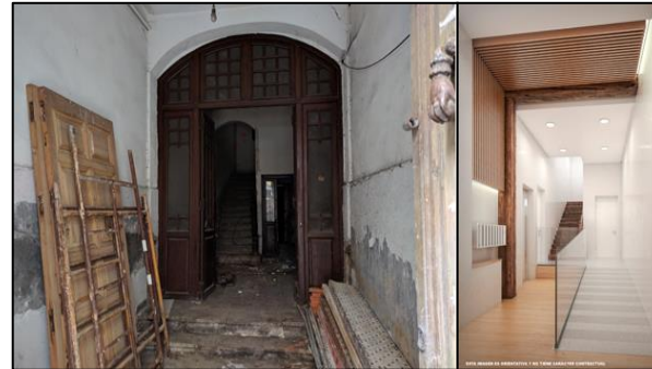
Rehabilitación arquitectónica interior del hall de una edificación histórica. Recuperado de: https://salineropampliega.com/2018/10/proyecto-de-rehabilitacion-de-edificio-de-viviendas.html
