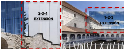
Figura 37. Fachada y materiales de la escuela de
